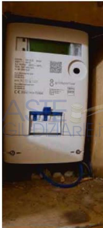
A tale dispositivo sono collegati conduttori che raggiungono, tramite corrugato sottotraccia, il quadro elettrico di distribuzione, posizionato sotto il dispositivo di misurazione, realizzato con un centralino in resina, con sportello e fissato su contenitore incassato nella muratura, al cui interno sono installati:
