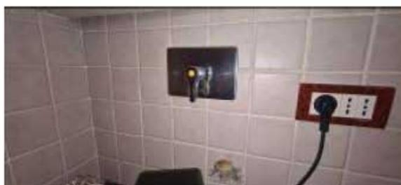
La tubazione è realizzata in metallo, ma non è stato possibile accertare le caratteristiche delle tubazioni sottotraccia, probabilmente anche quest'ultime in metallo, e della rete interna, per cui non è possibile esprimere parere in merito alla rispondenza alle vigenti UNI 7129.
