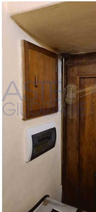
Al quadro elettrico di distribuzione, sono collegati conduttori che raggiungono, tramite corrugati sottotraccia, un ulteriore quadro elettrico, posizionato all'interno dell'appartamento, realizzato con un centralino in resina, con sportello e fissato su contenitore incassato nella muratura, al cui interno sono presenti:
