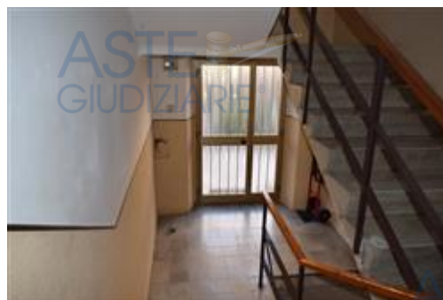
VANO SCALE D'ACCESSO AGLI ALLOGGI
