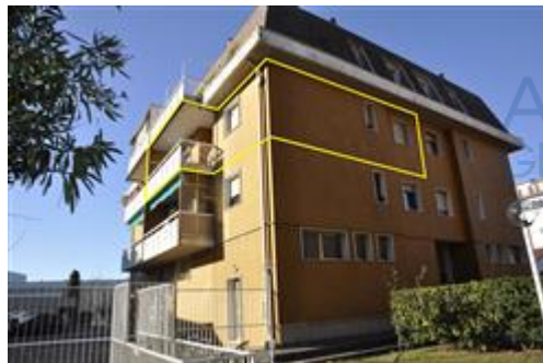
Vista dall'area scoperta condominiale
