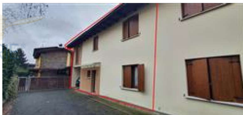
Edificio pignorato - Fronte
