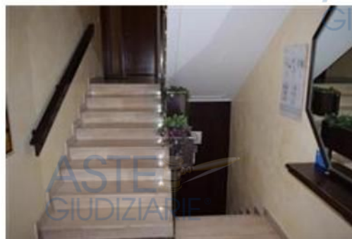
VANO SCALE COMUNE
