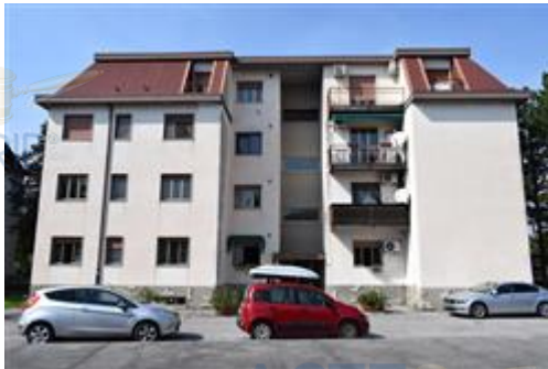
FACCIATA PRINCIPALE INGRESSO STABILE
