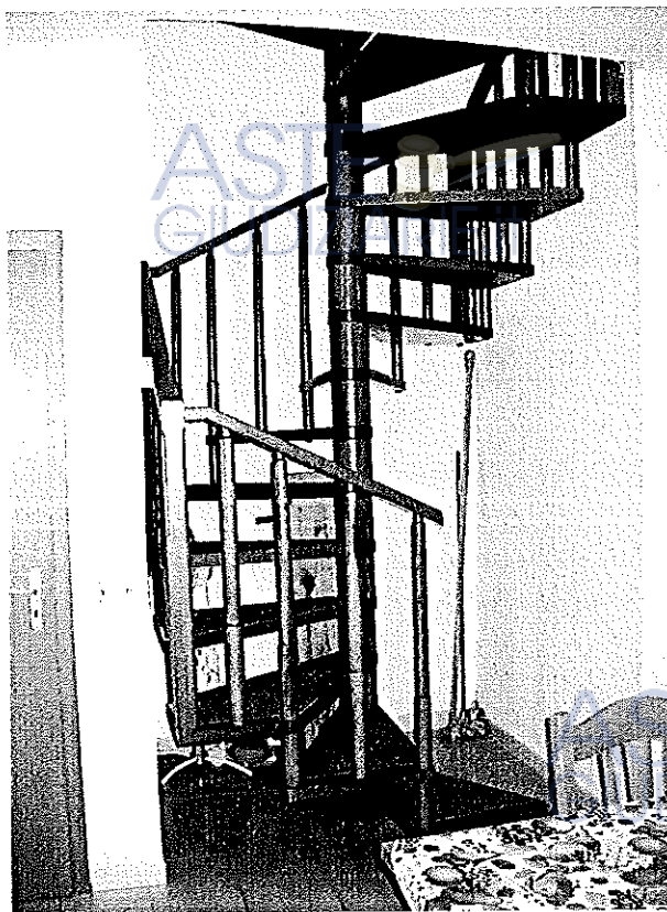
Foto n°30: Scala a chiocciola per accedere al piano superiore
