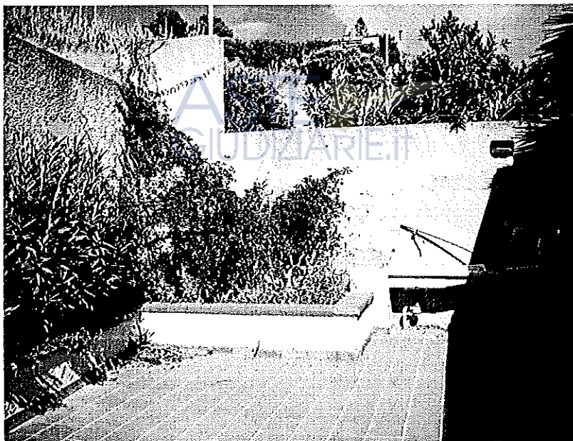
Foto n°20: Parte posteriore esterna del fabbricato, si possono osservare le aiuole ed il muro di con fine perimetrale.
