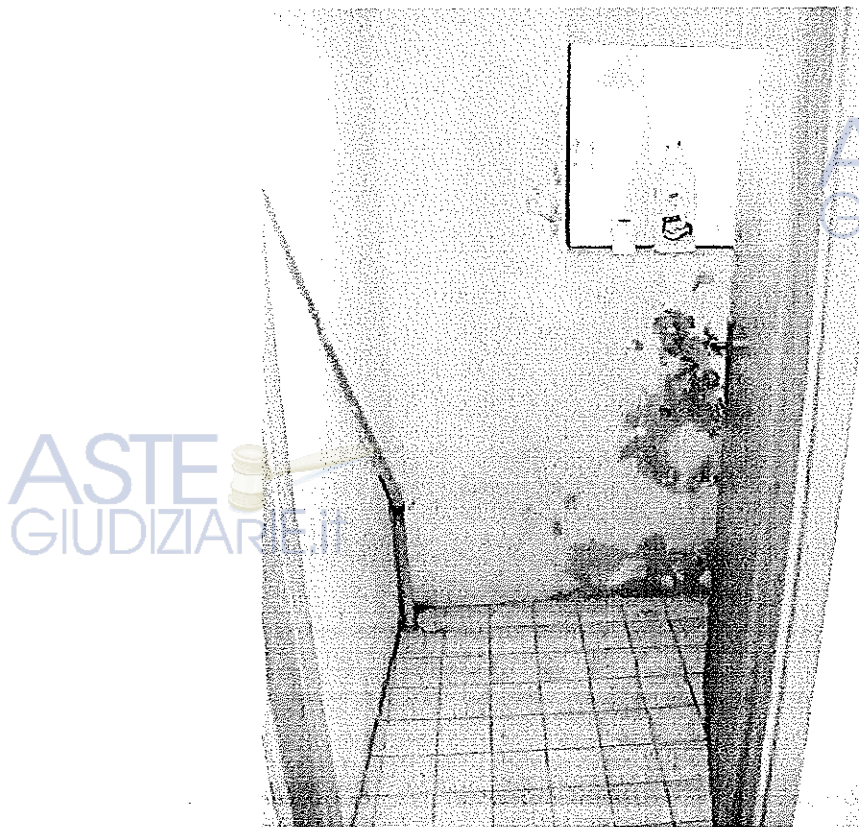
Foto n°9: Vista della porta di ingresso al bagno, della finestra e di parte delle pareti intonacate.
