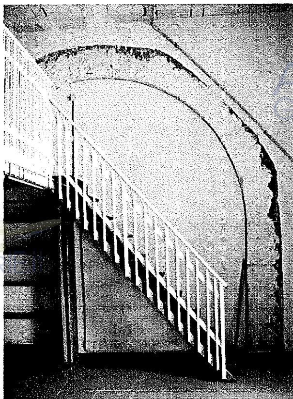
Foto n°13: Scala di accesso al soppalco
