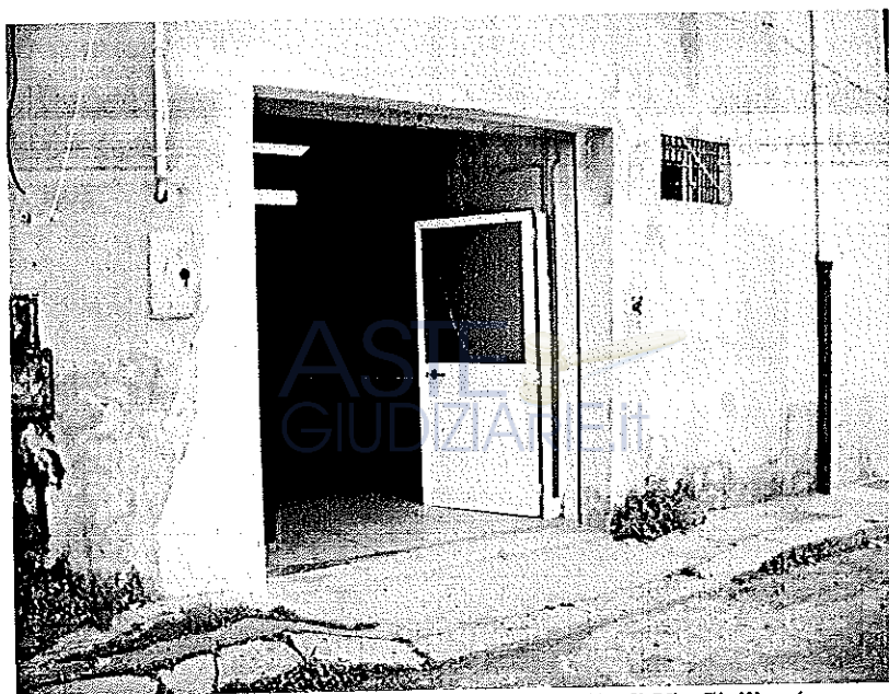
Foto n°2: Vista dell'ingresso all'immobile di Via Sicilia, 4
