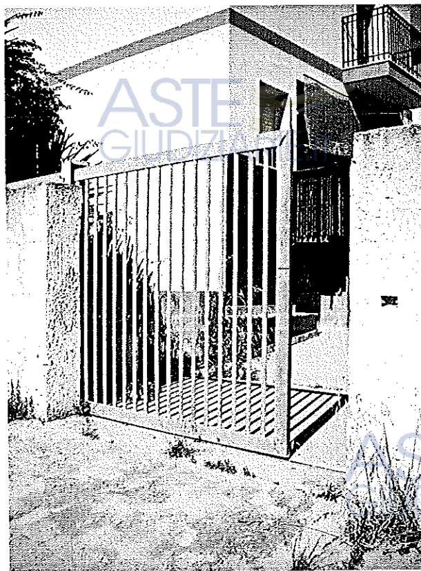
Foto n°18: Vista del cancello di ingresso metallico non meccanizzato.
