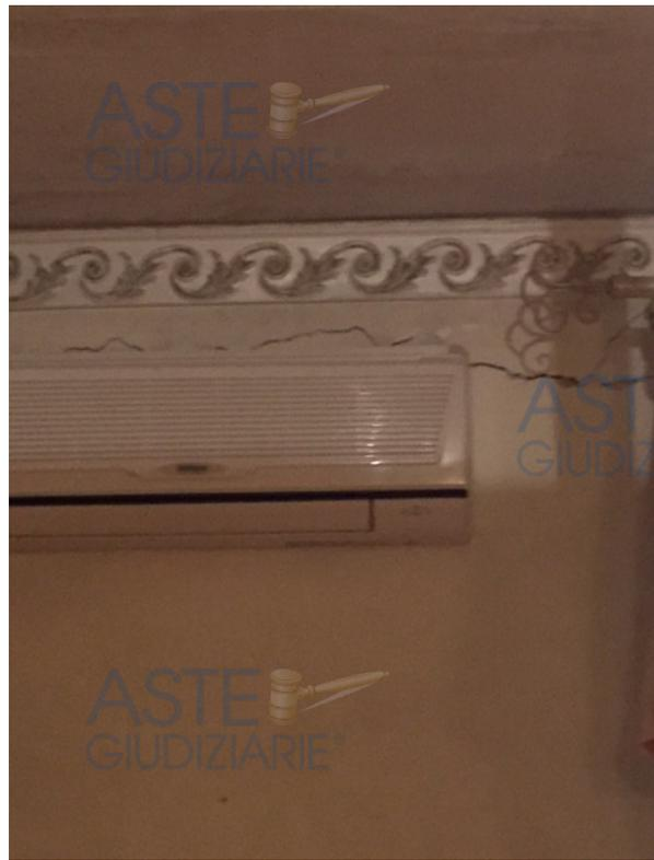
Foto 11 e 12 - Dissesti statici rilevati a secondo piano: fenomeni di sfondellamento e lesioni strutturali
