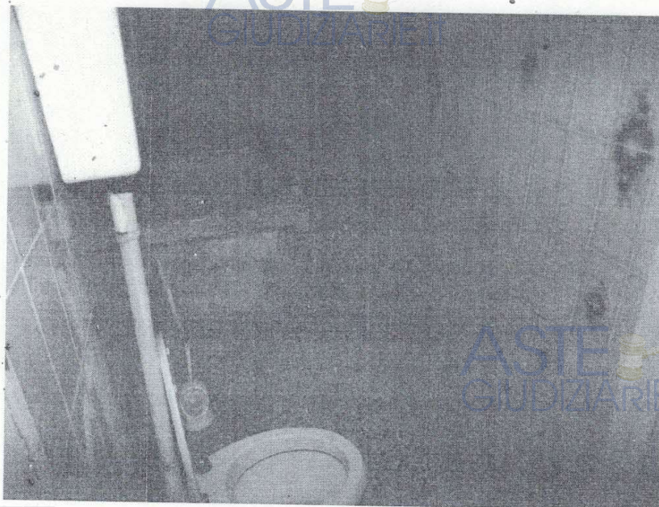
Foto n° 6 – Immobile in Niscemi nella via Venezia n° 47, piano terra, foglio 31, part. 1023, sub 3 (graffata part. 1305 sub 5) – Panoramica del servizio igienico posizionato nel sotto scala.
