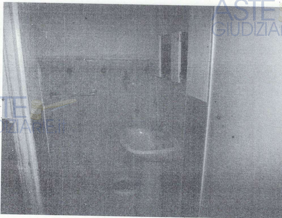
Foto n° 5 – Immobile in Niscemi nella via Venezia n° 47, piano terra, foglio 31, part. 1023, sub 3 (graffata part. 1305 sub 5) – Panoramica del servizio igienico posizionato nel sotto scala.
