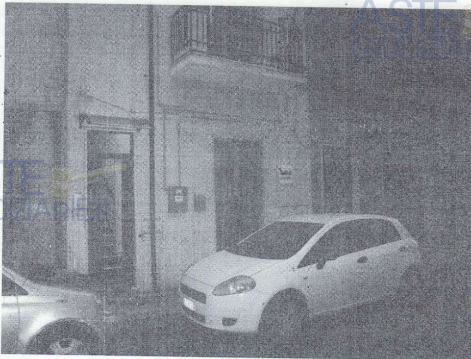
Foto n° 1 – Immobile in Niscemi nella via Venezia n° 47, piano terra, foglio 31, part. 1023, sub 3 (graffata part. 1305 sub 5) – Panoramica del prospetto su via Venezia.
