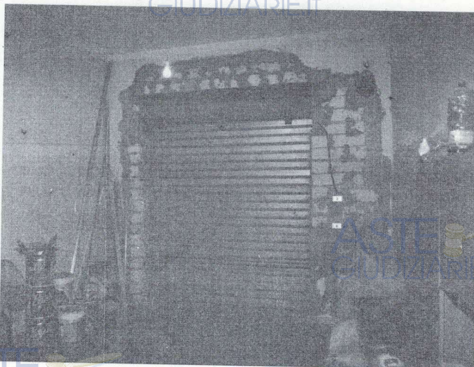
Foto n° 10 – Immobile in Niscemi nella via Venezia n° 47, piano terra, foglio 31, part. 1023, sub 3 (graffata part. 1305 sub 5) – Panoramica del vano prospiciente la via Cagliari.
