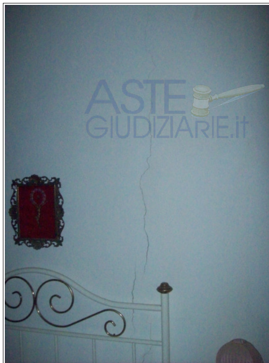
Foto n° 20: Interno | primo piano | particolare delle lesioni
