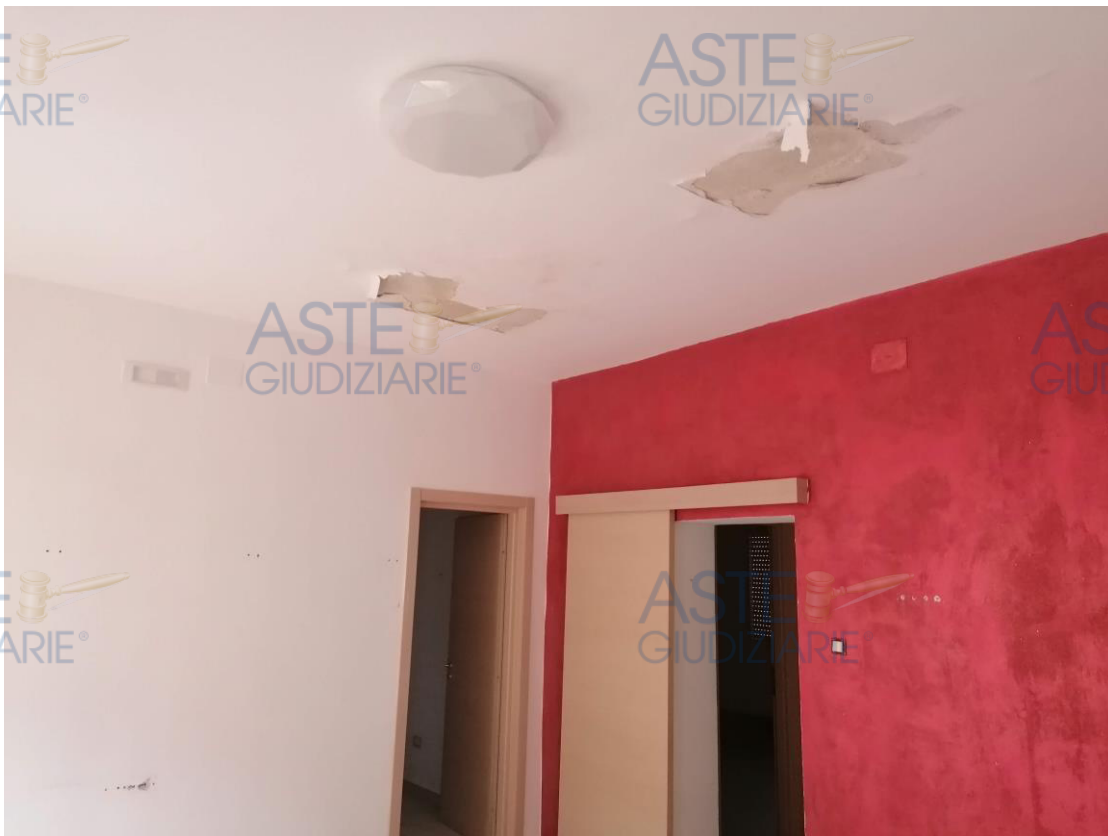
Foto n° 9 – Unità immobiliare al 2° piano del fabbricato sito in Gela nella via Monti 3. In Catasto al foglio 177 part.IIIa 115 sub 6; Soggiorno, screpolature della tinteggiatura dovute ad infiltrazioni d'acqua provenienti dal lastrico solare.
