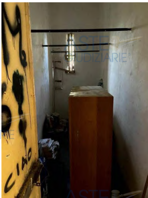
Foto 8 – Interno magazzino a piano terra
