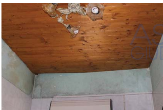
Foto 7 e 8 - Particolare dell'intradosso del solaio del bagnetto controsoffittato con perline di legno ed ingresso dell'appartamento a piano terra
