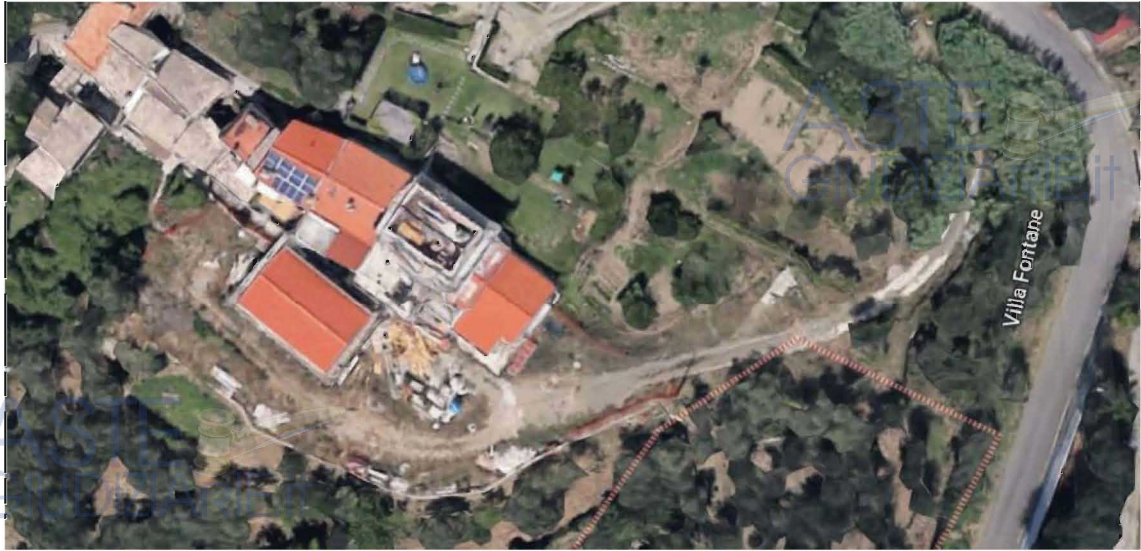
Figura 13 – Immagine aerea zona di interesse
