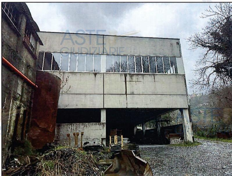
struttura portante in c.a., attualmente ancora da completare per la mancanza dei tamponamenti perimetrali esterni (superficie mq. 580 – altezza interna mt. 4,50), dotato di
