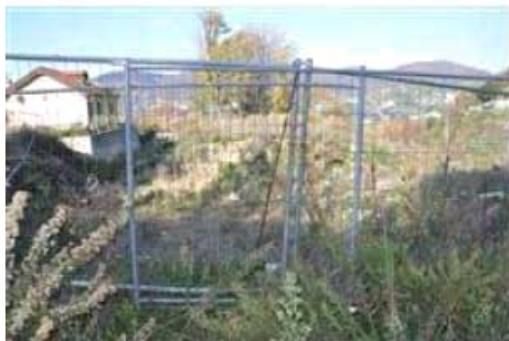
Vista Corpo A
