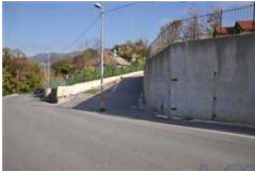
Vista strada di accesso per i settori 6-7
