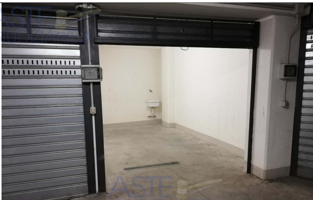
Vista esterna box
