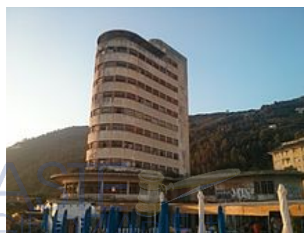
La Colonia Fara di Chiavari (GE) nello stato di degrado al 7 settembre 2014
