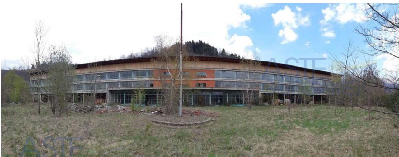
Foto 8 – Vista panoramica dell'Edificio 1
