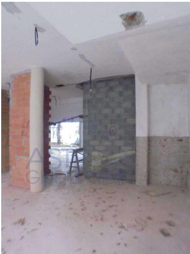
Foto 32 - Vista della zona di disimpegno degli ascensori
