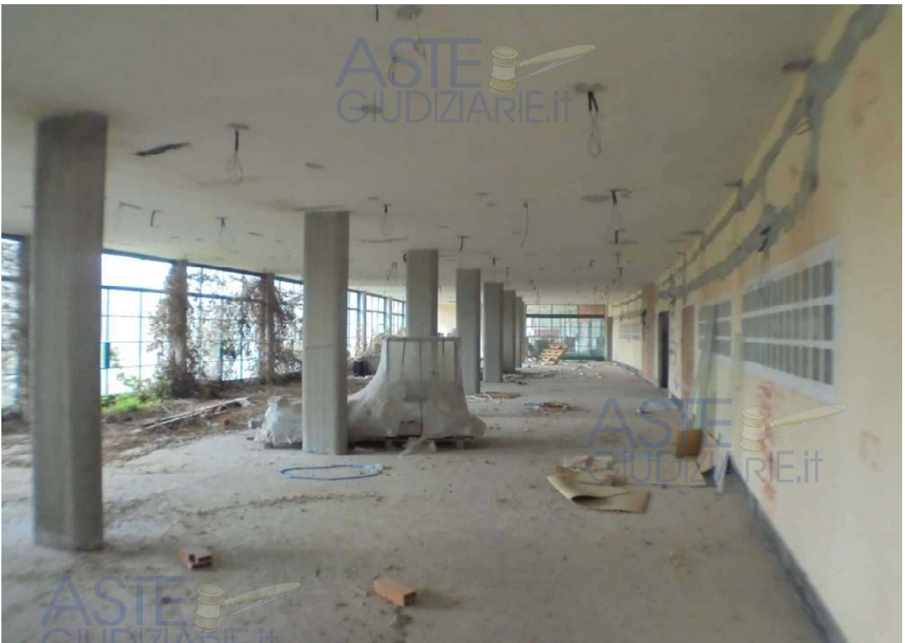
Foto 29 – Vista dell'ex refettorio centrale
