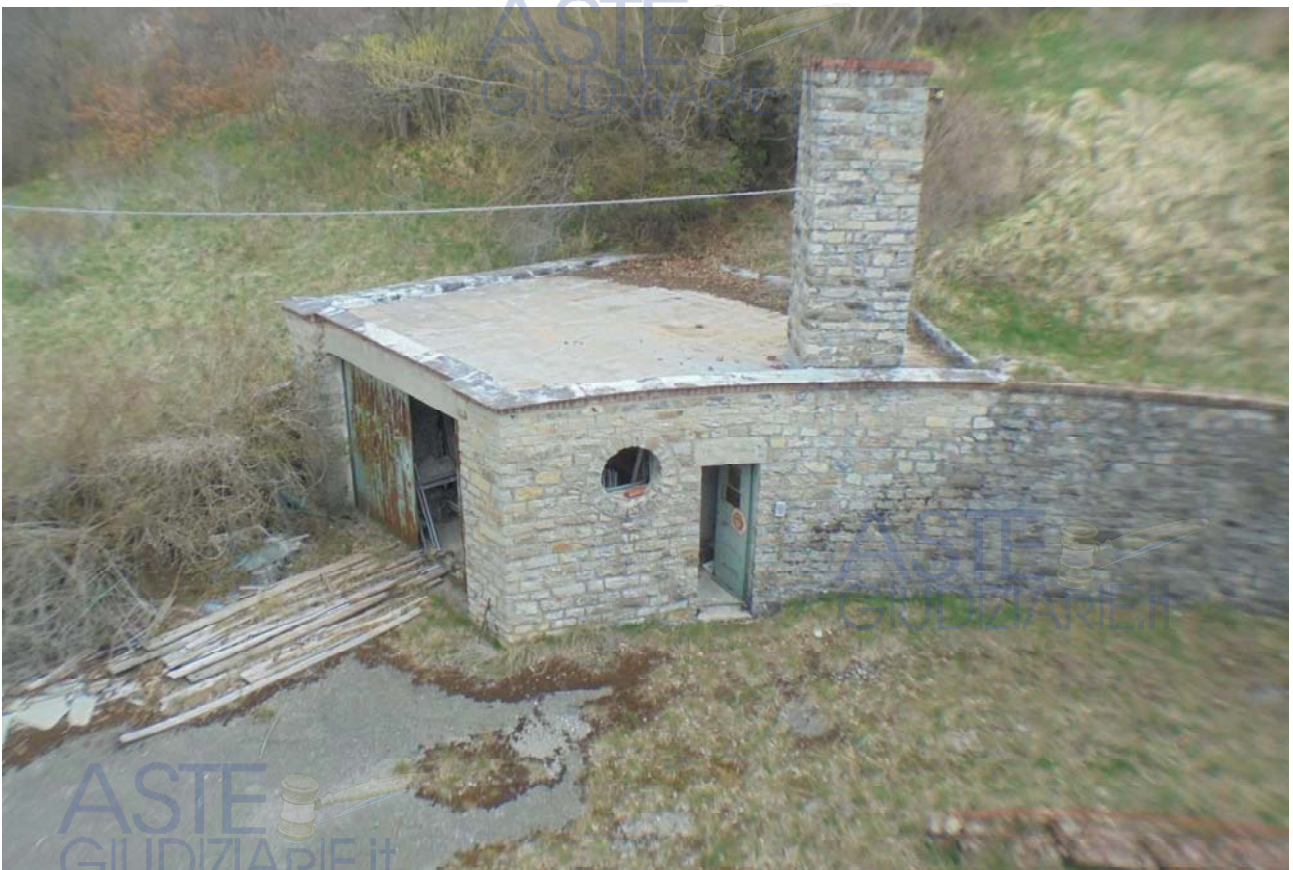
Foto 91 – Foto di insieme del locale tecnico/autorimessa (Edificio 3)
