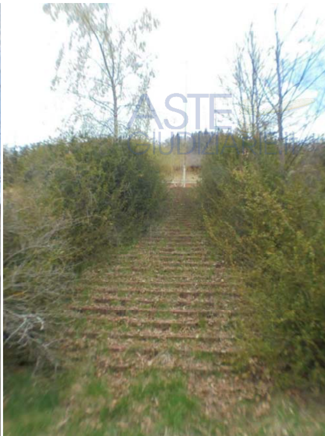
Foto 21 - Vista della scalinata esterna che collega con il terreno sottostante
