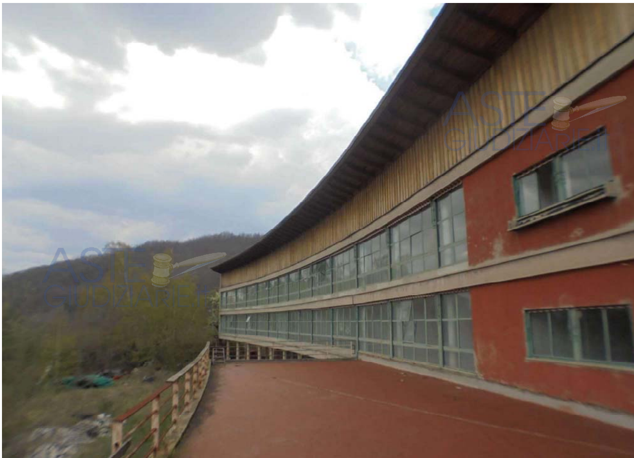
Foto 42 – Vista della terrazza panoramica dell'ala SX dell'Edificio 1
