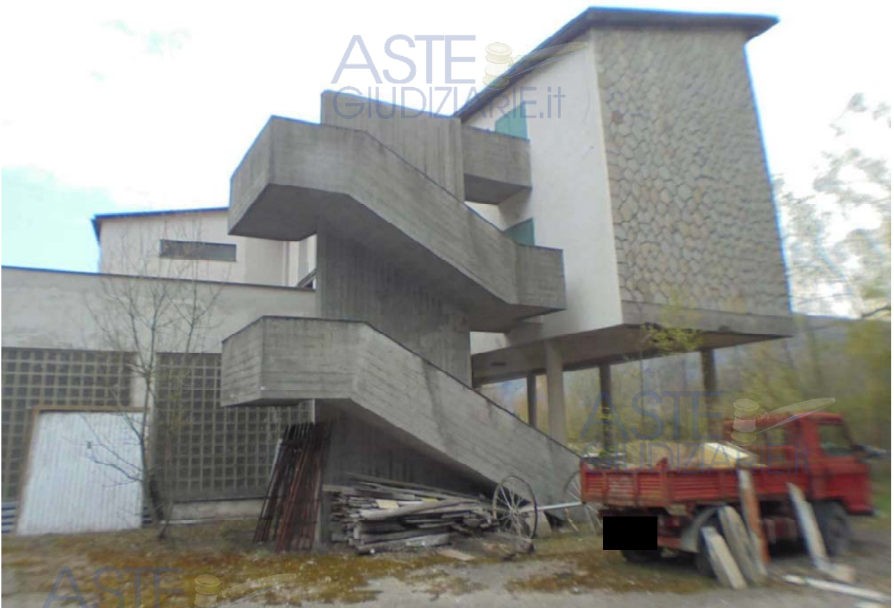
Foto 25 – una delle due scale di servizio, di testa al prospetto SX, oggetto del lavoro di ristrutturazione dell'edificio
