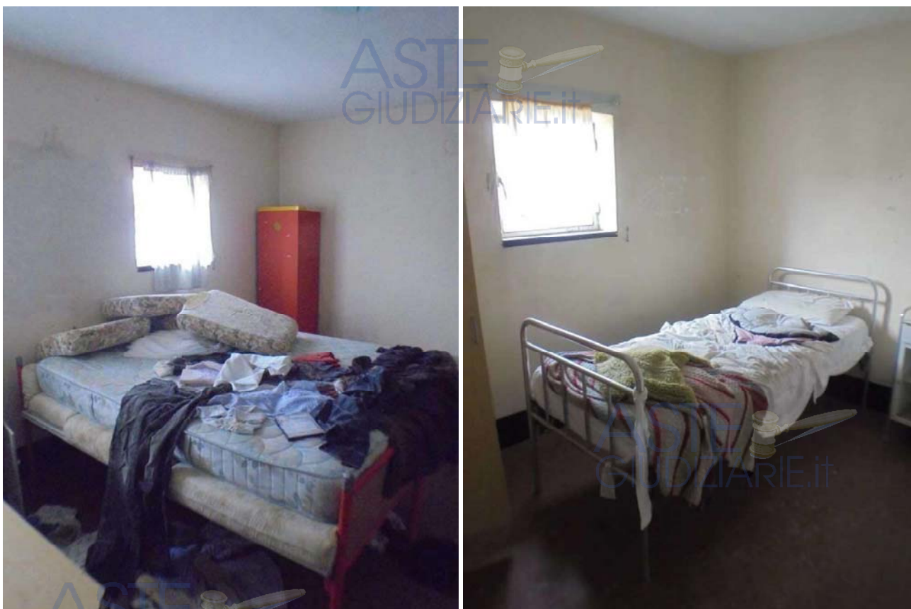
Foto 88 e 89 – Foto di alcuni spazi del 2° piano dell'Edificio 2
