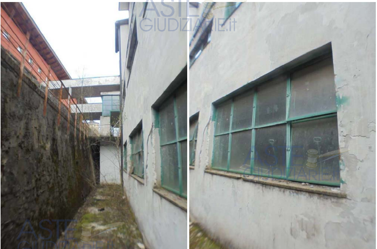
Foto 74 e 75 - Vista dell'intercapedine lato monte
