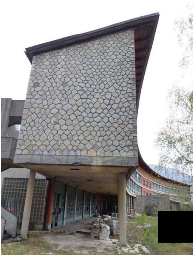
Foto 12 - Vista del prospetto SX dell'Edificio 1
