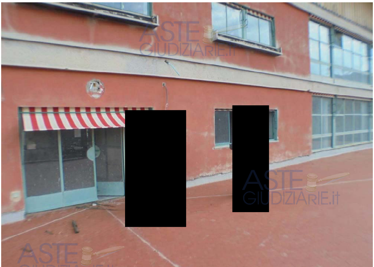
Foto 47 – Dettaglio della porta finestra della terrazza panoramica “a misura di bimbo”
