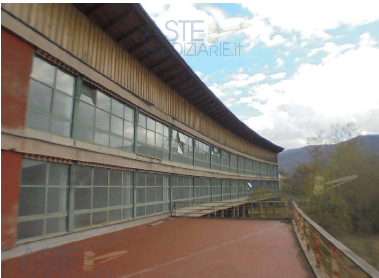
Foto 43 – Vista della terrazza panoramica dell'ala DX dell'Edificio 1
