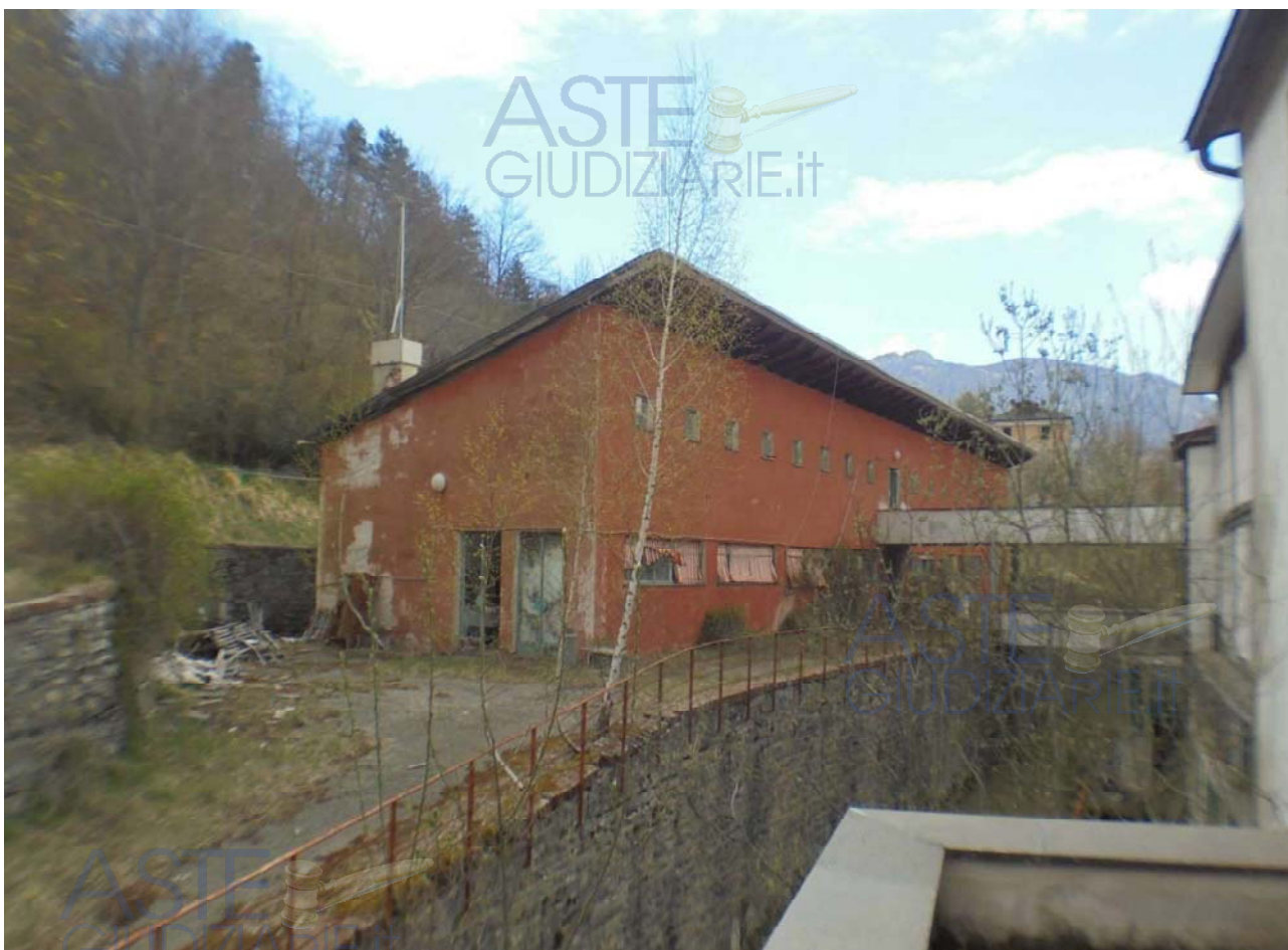
Foto 81 e 82 – Foto di insieme del corpo dell’Edificio 2
