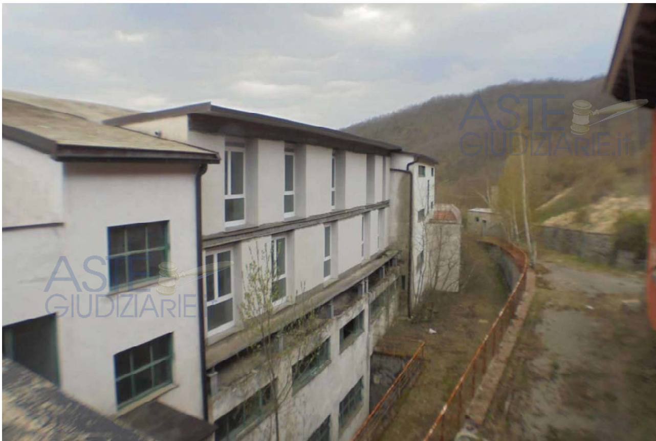
Foto 56 - Vista lato SX dei nuovi volumi realizzati sul progetto del '97
