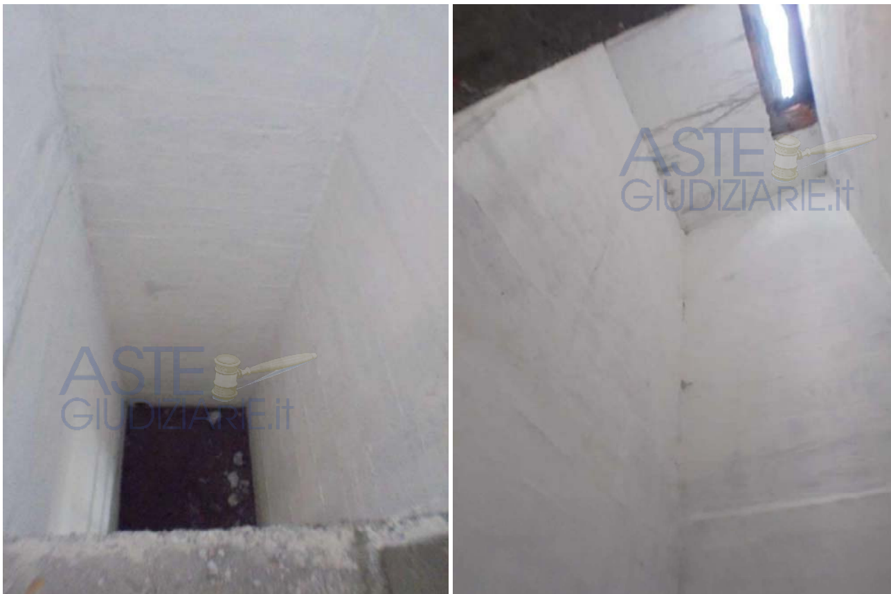
Foto 39 e 40 – Vista del vano ascensore, oggetto del lavoro di ristrutturazione dell'edificio
