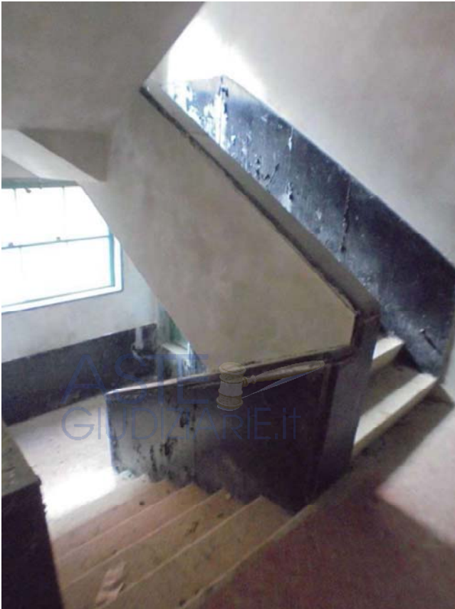
Foto 48 - Vista del vano scale di servizio
