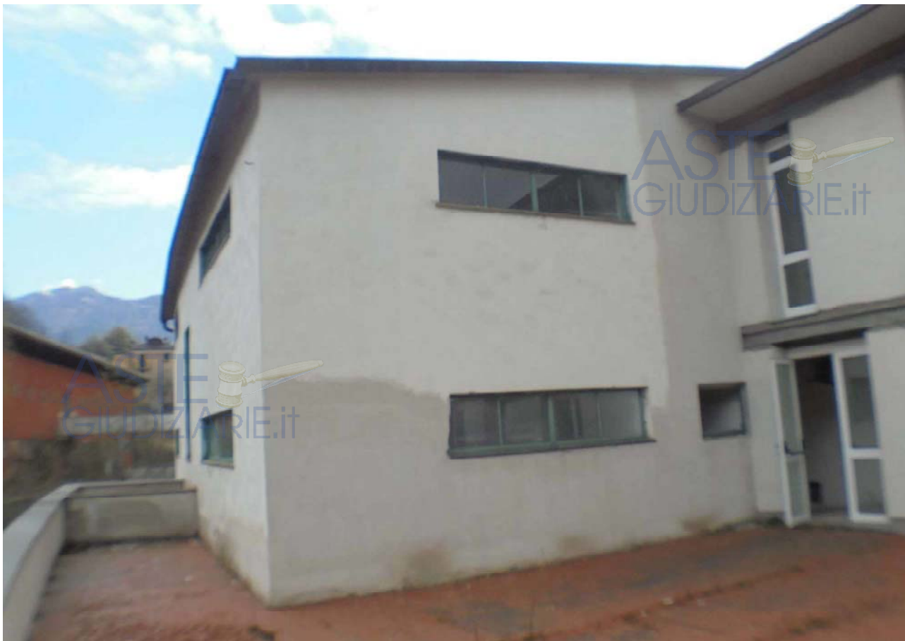
Foto 62 - Vista del volume originale del '39 rispetto al volume nuovo del '97
