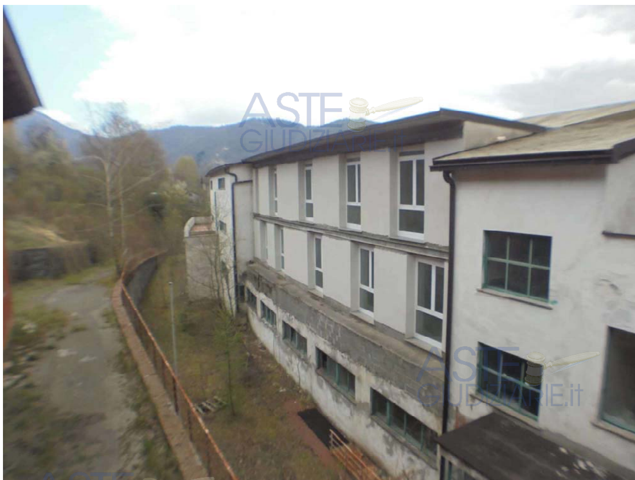
Foto 55 - Vista lato DX dei nuovi volumi realizzati sul progetto del '97
