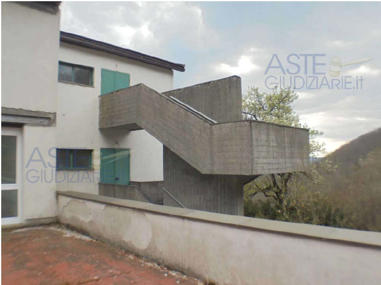
Foto 64 - Vista di una delle due scale di servizio esterne oggetto dei lavori legati alla partica edilizia del '97 (Pratica n. 95/1997)
