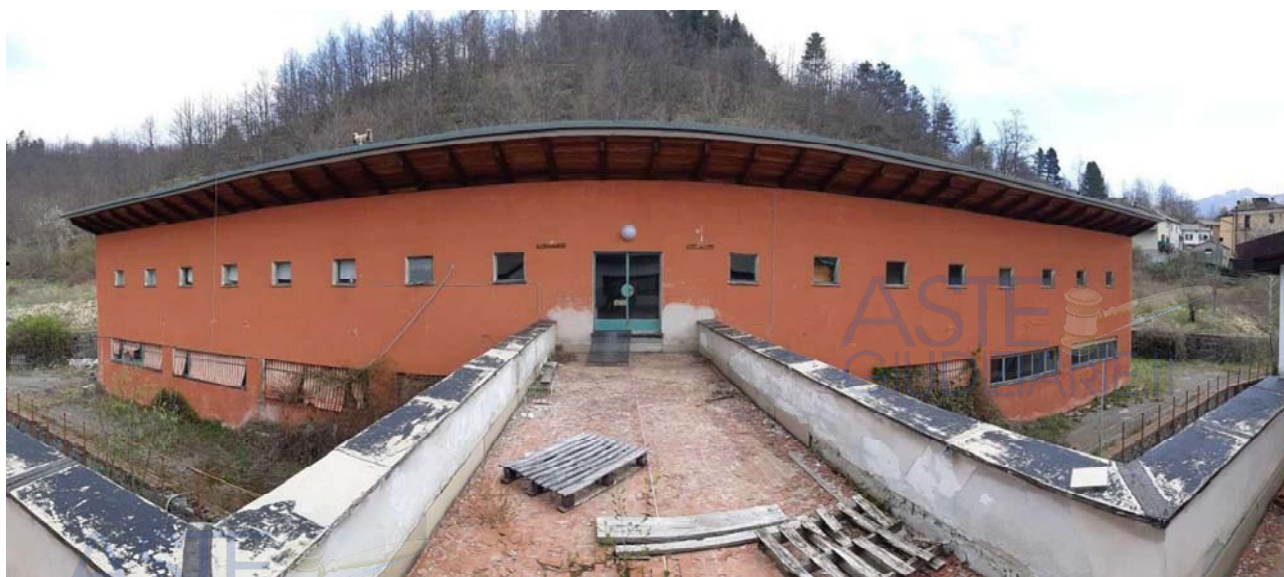
Foto 80 – Foto panoramica (grandangolo) dell'Edificio 2 arrivando dalla passerella che lo collega edificio principale (Edificio 1).
