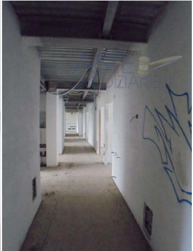
Foto 49 - Vista del corridoio di disimpegno (ala SX) di collegamento alle camere singole di degenza del piano 1°
