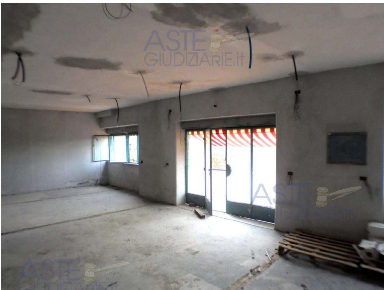
Foto 41 – Vista del locale di disimpegno che porta alla terrazza panoramica
