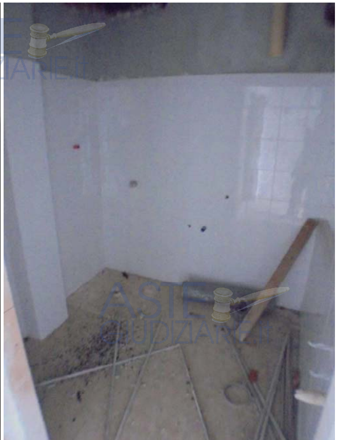
Foto 51 - Vista di uno di un bagno tipo dedicato alla camera singola
