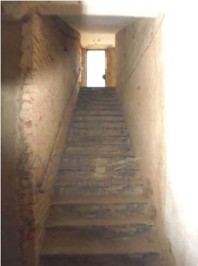
Foto 72 - Vista della scala di servizio
