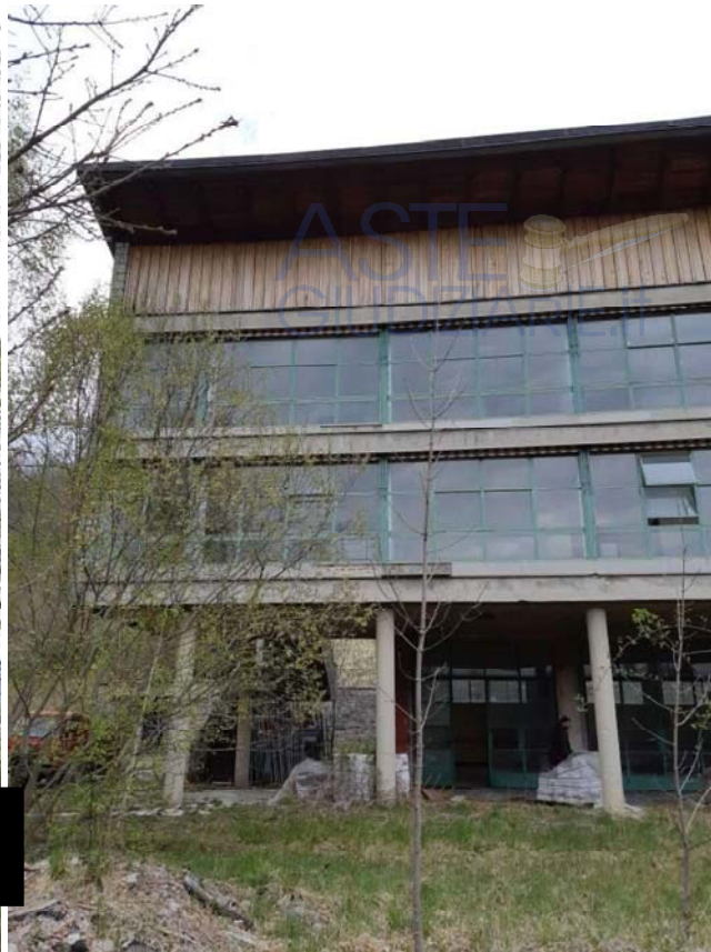
Foto 13 - Vista di dettaglio della facciata dell'Edificio 1
