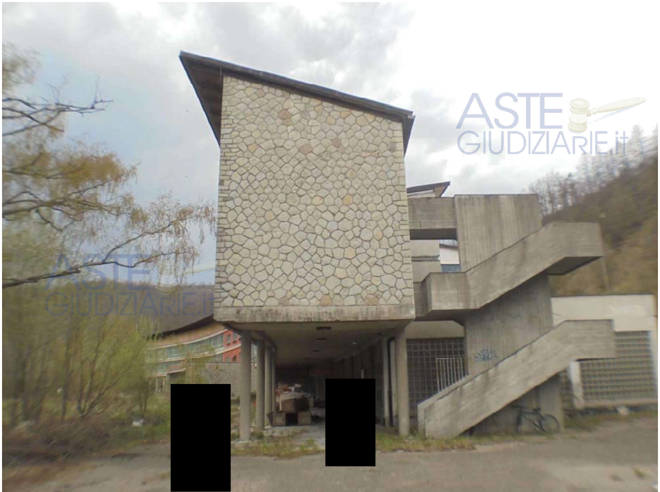
Foto 16 - Vista del prospetto DX dell'Edificio 1
