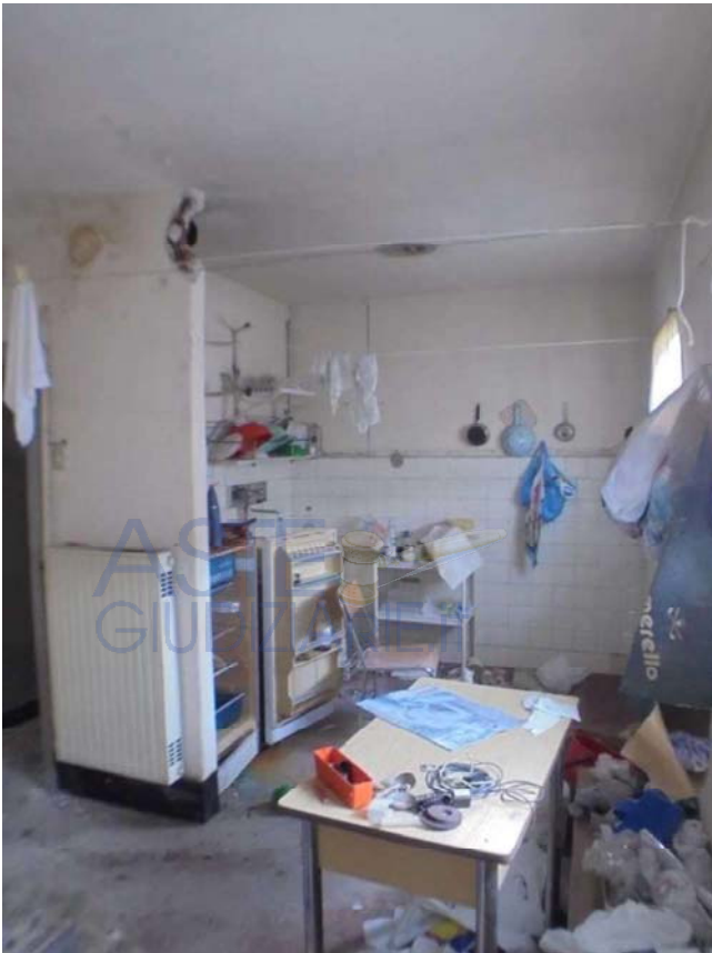
Foto 90 – Foto di alcuni spazi del 2° piano dell'Edificio 2 Locale adibito a cucina di cantiere da parte dell'impresa appaltante dei lavori del '97
