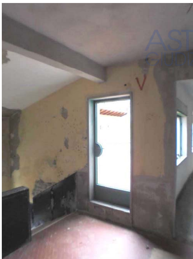
Foto 65 - Vista dell'arrivo di una delle scale di servizio che collegano il 1° al 2° piano
