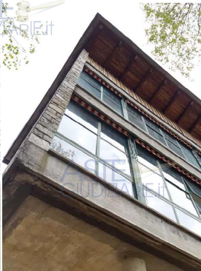
Foto 11 - Vista di dettaglio della facciata dell'Edificio 1
