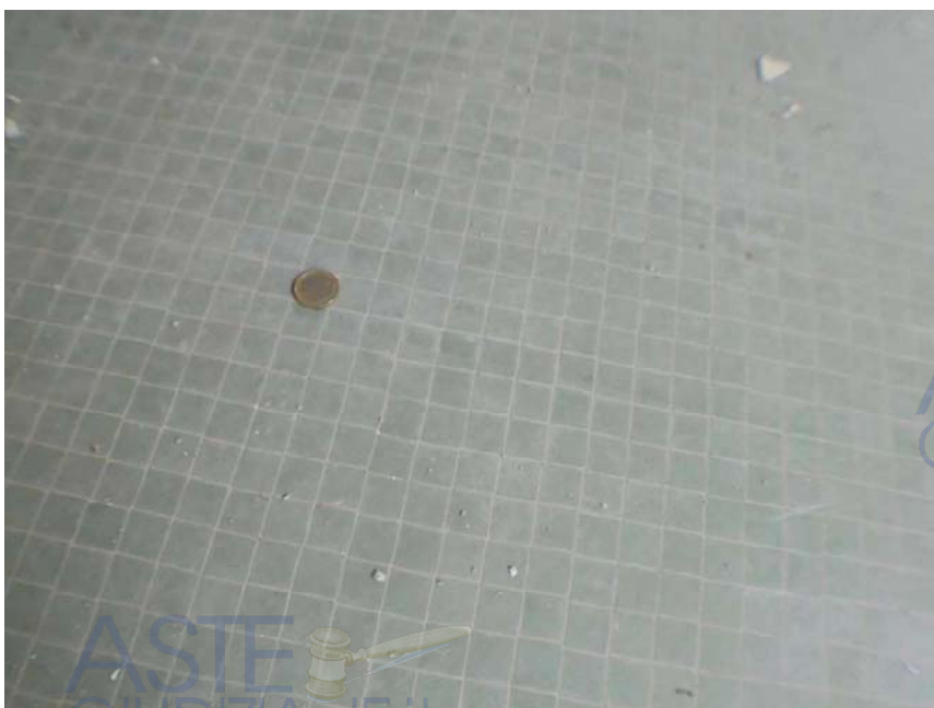
Foto 38c – Dettaglio del pavimento originale in mosaico di gress porcellanato
