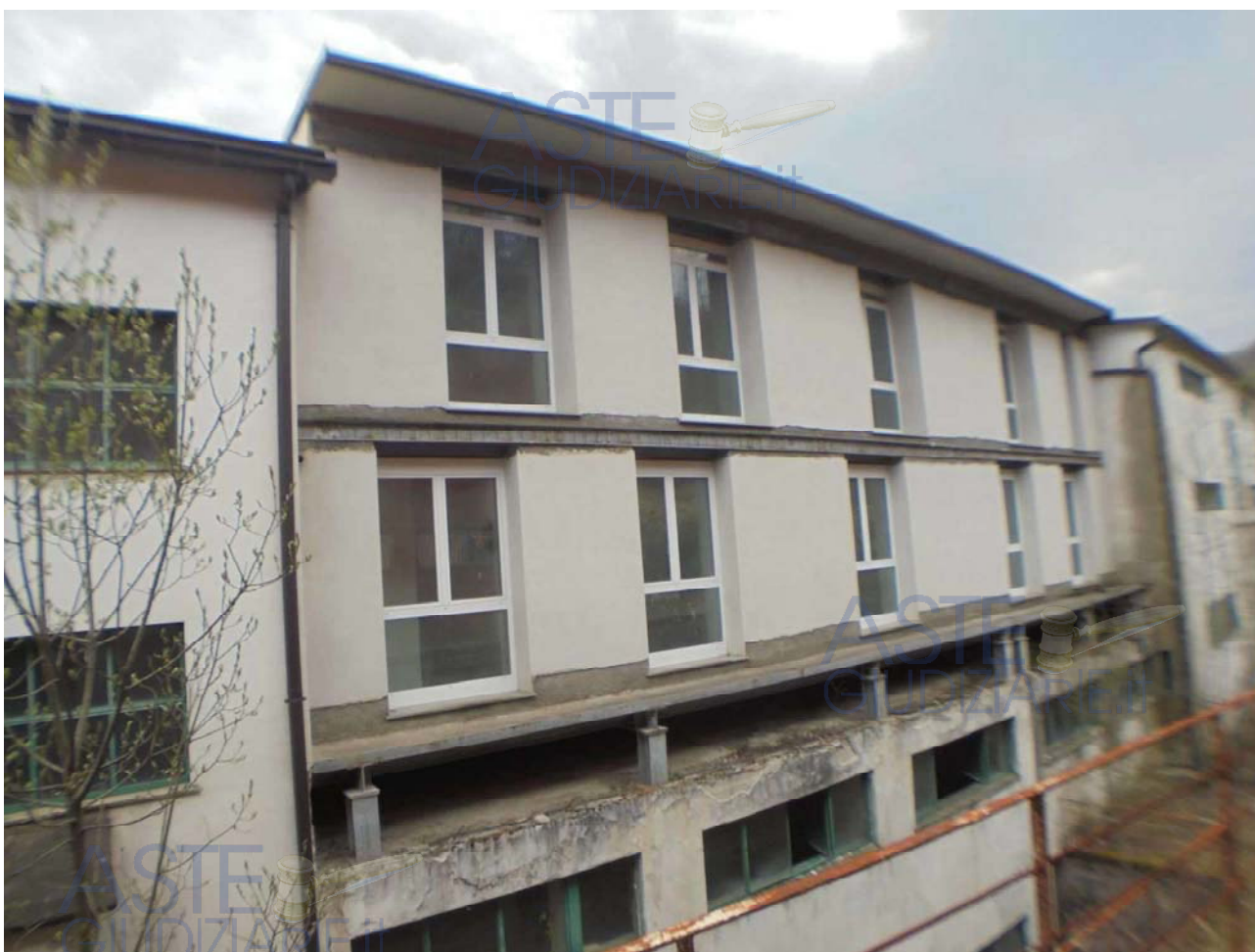
Foto 59 - Vista di uno dei 4 volumi realizzati sul progetto del '97
