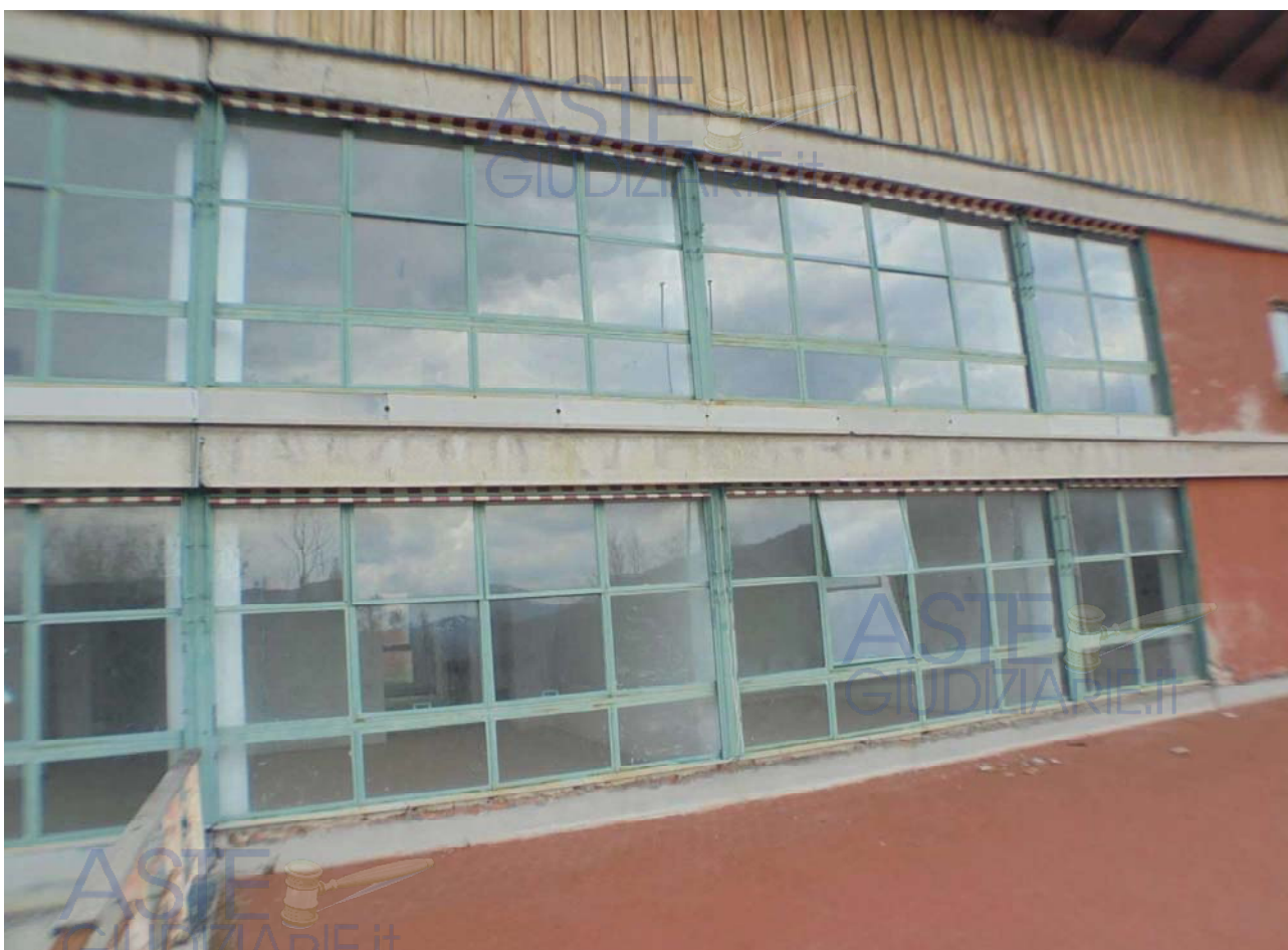
Foto 45 – Dettaglio delle finestre a bilico
