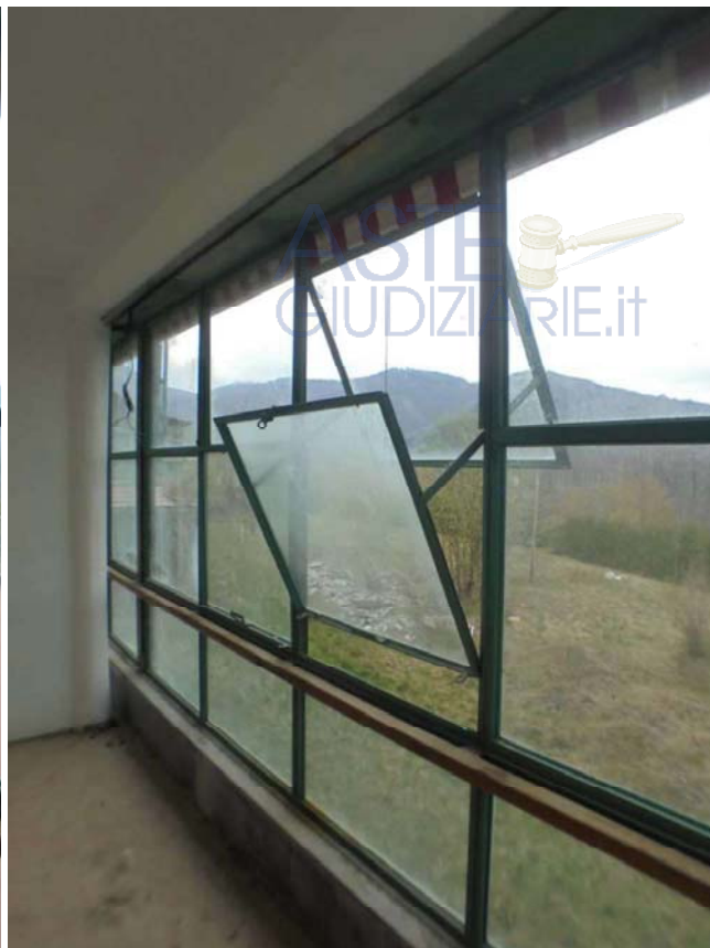
Foto 52 e 53 – Dettaglio delle aperture a “Vasistas” delle finestre delle camere
