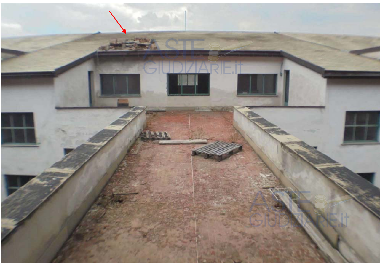
Foto 57 - Vista dell'ala centrale col ponte che collega l'Edificio 1 all'Edificio 2
