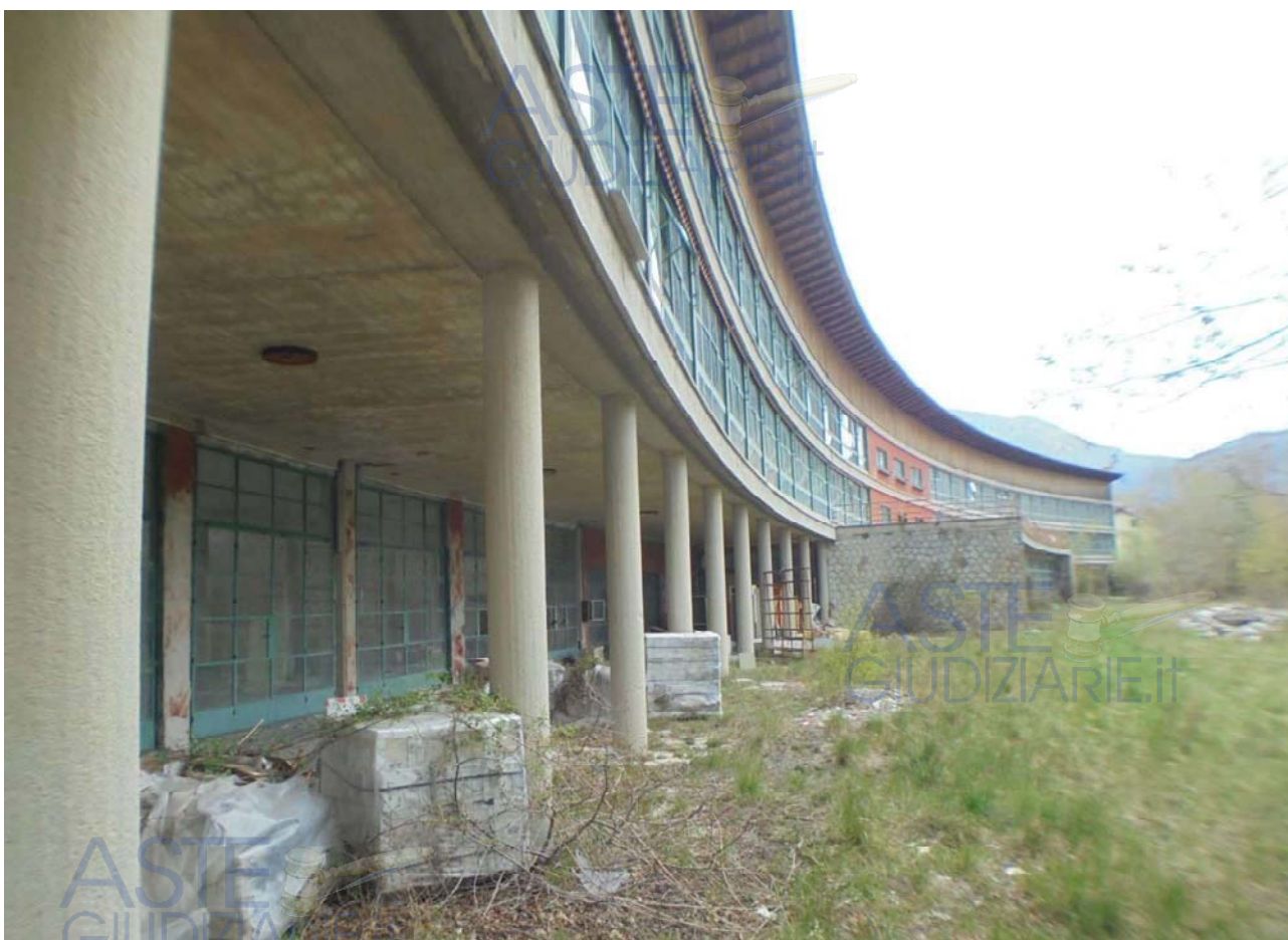
Foto 27 – il patio dell'ala SX dell'edificio
