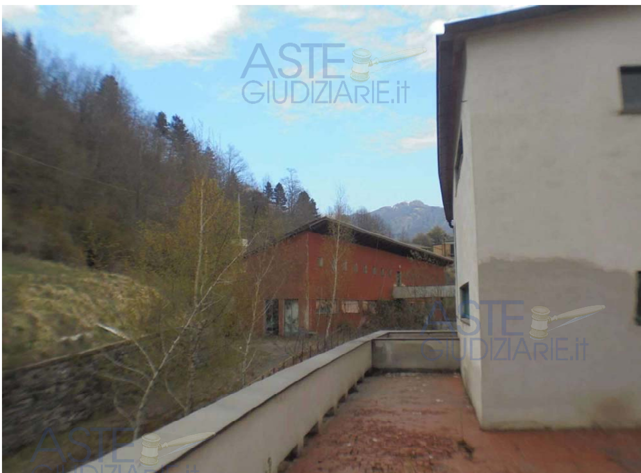
Foto 63 - Vista dalla terrazza lato monte dell'Edificio 2
