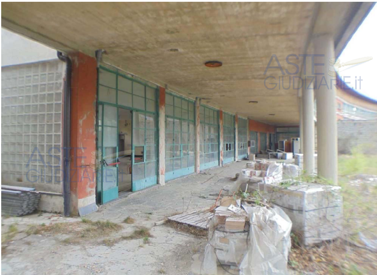
Foto 26 – il patio dell'ala SX dell'edificio
