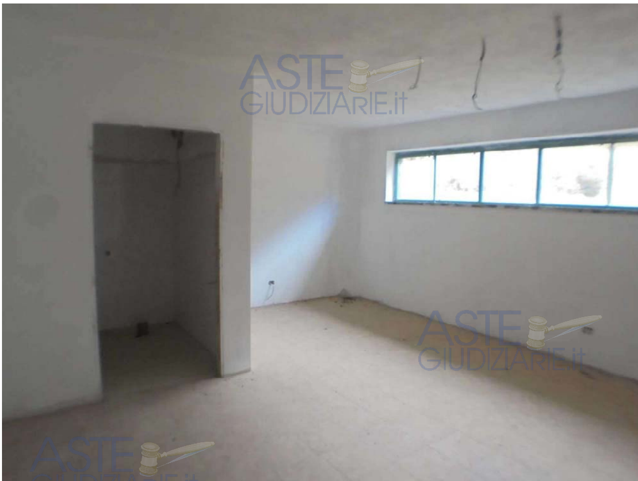
Foto 69 - Vista di una delle stanze degli alloggi (con il locale bagno)
