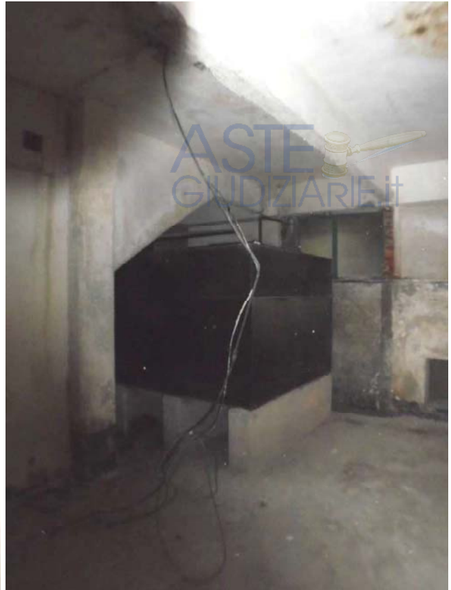
Foto 73 - Vista del serbatoio ex centrale termica
