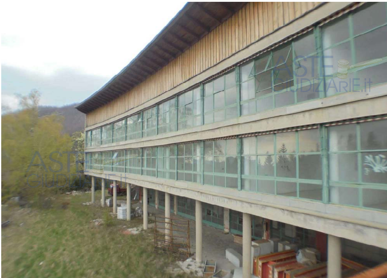
Foto 44 – Vista della terrazza panoramica dell'ala SX dell'Edificio 1
