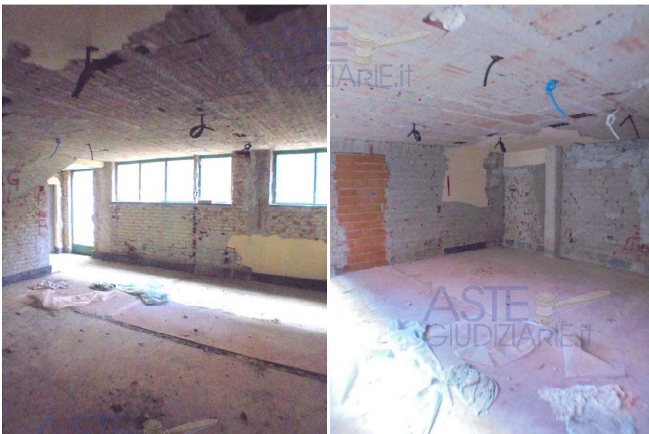
Foto 70 e 71 - Vista di uno dei locali del piano seminterrato
