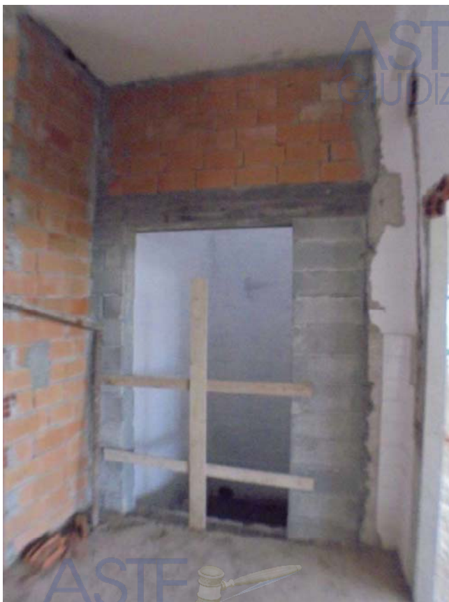
Foto 34 - Vista del vano ascensore
