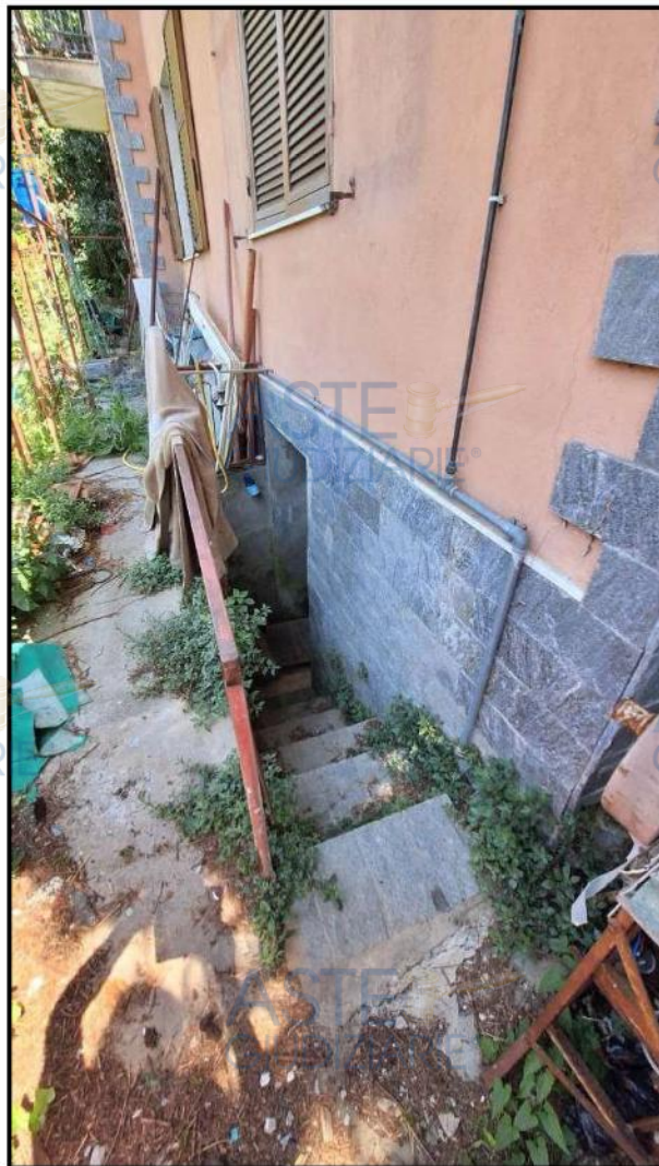
FOTO N. 18 – Accesso alla cantina interrata
