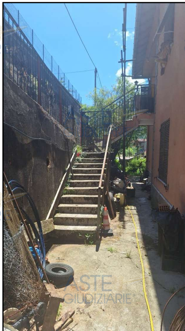
FOTO N. 22 – Scale di collegamento con il piano strada
