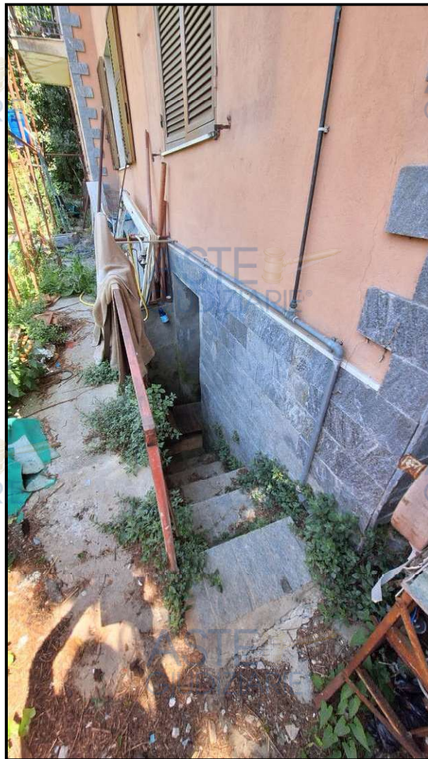
FOTO N. 18 – Accesso alla cantina interrata
