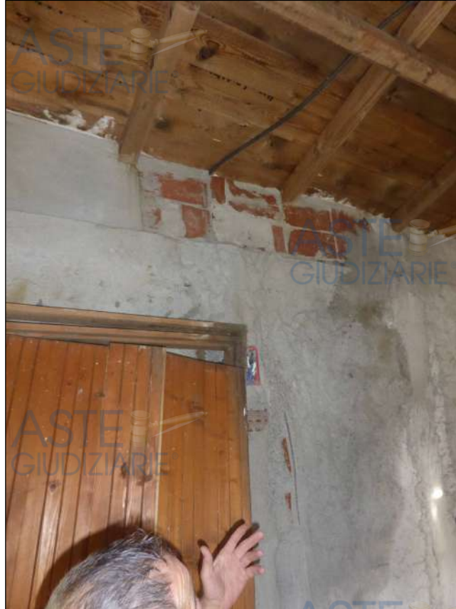
FOTOGRAFIA N. 49 Particolare della sopraelevazione
