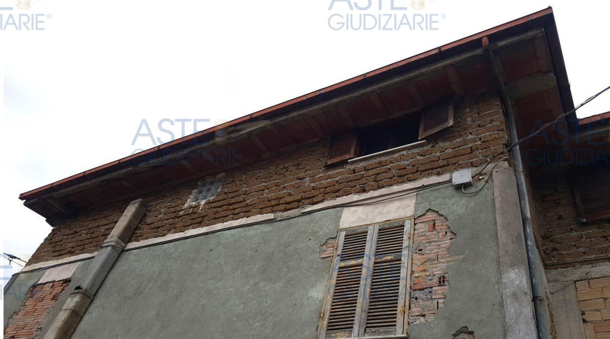
Lato ovest (limitrofo al viale di accesso)
