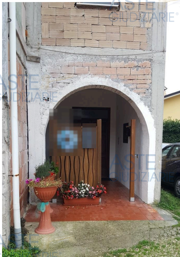
Lato ovest (ingresso comune che consente l'accesso al vano scala)
