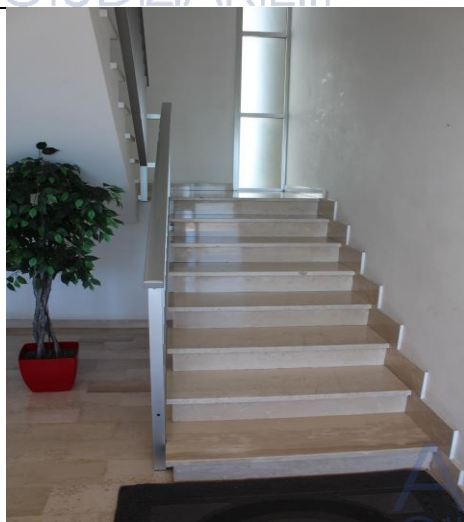
PARTICOLARE INGRESSO PIANO TERRA E SCALA COMUNE DI ACCESSO AGLI APPARTAMENTI
