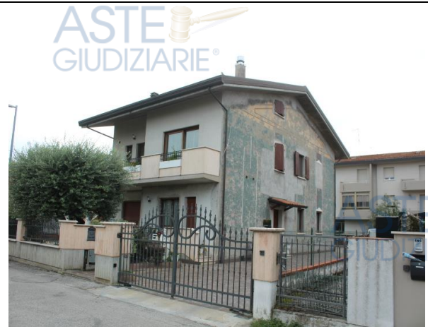
PROSPETTO PRINCIPALE SU VIA TICINO E LATO NORD A DESTRA
