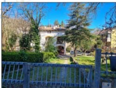
FOTO 8 - LOTTO B e C Ingresso carrabile
