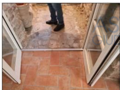
FOTO 109 - LOTTO D Dettaglio pavimento
