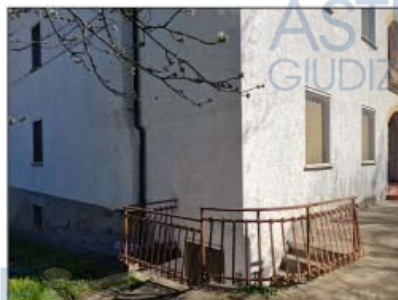
FOTO 17 - LOTTO B e C Ingresso cantina p.seminterrato
