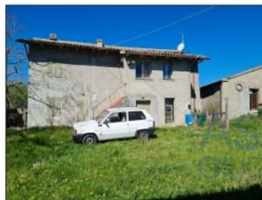
FOTO 66 - LOTTO D Vista abitazione
