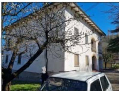
FOTO 5 - LOTTO B e C Vista del fabbricato
