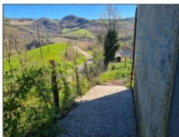
FOTO 92 - LOTTO D Marciapiede e area esterna
