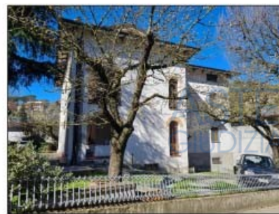
FOTO 6 - LOTTO B e C Prospetto principale
