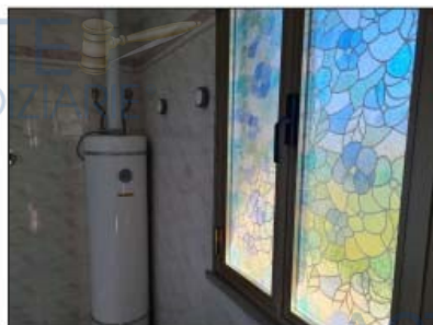
FOTO 112 - LOTTO D Bagno
