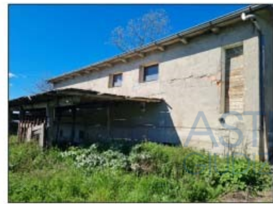
FOTO 81 - LOTTO D Deposito, ricovero animali e tettoia.
