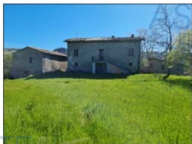
FOTO 70 - LOTTO D Vista della proprietà confinante
