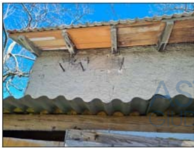
FOTO 79 - LOTTO D Dettaglio copertura
