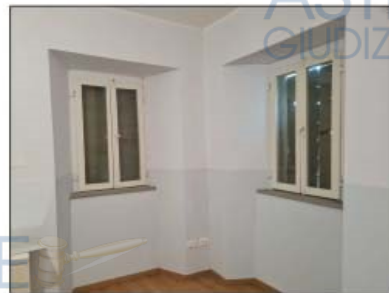
FOTO 108 - LOTTO D Dettaglio muratura e finestre
