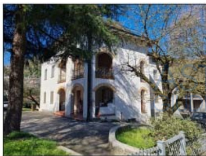
FOTO 4 - LOTTO B e C Vista del fabbricato
