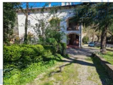
FOTO 9 - LOTTO B e C Viale d'accesso privato
