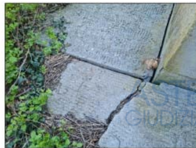
FOTO 99 - LOTTO D Deposito assestamento marciapiede
