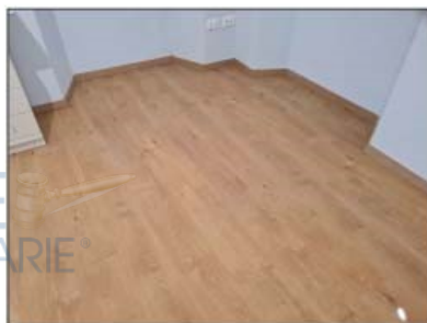
FOTO 116 - LOTTO D Dettaglio pavimento
