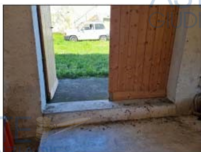
FOTO 82 - LOTTO D Ingresso deposito
