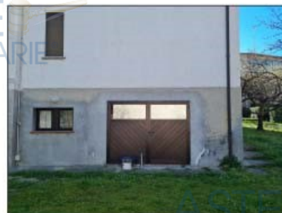
FOTO 18 - LOTTO B e C Portone autorimessa
