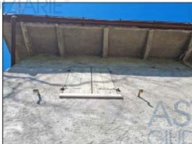
FOTO 88 - LOTTO D Dettaglio copertura e cornicione
