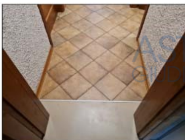
FOTO 34 - LOTTO C Dettaglio pavimenti ingresso
