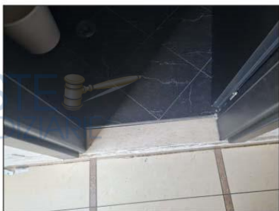
FOTO 91 - DETTAGLIO PAV. BAGNO
