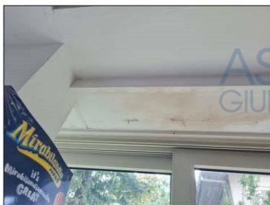
FOTO 97 - INFILTRAZIONE CONTROS.
