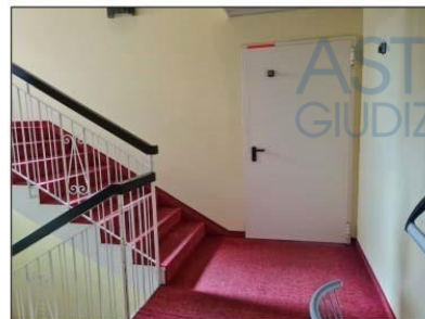
FOTO 96 - PAVIMENTO VANO SCALA
