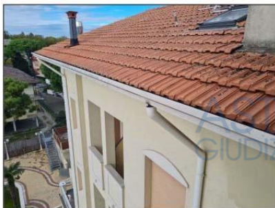
FOTO 14 - VISTA DELLA COPERTURA
