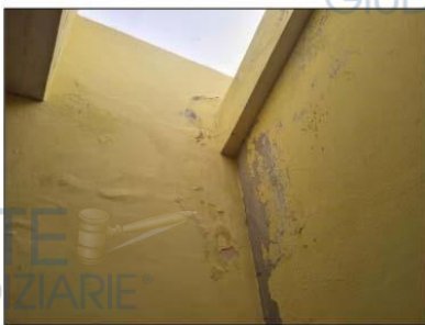
FOTO 101 - INFILTRAZIONE COPERT.
