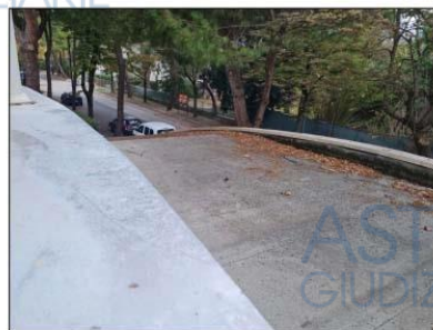
FOTO 45 - VISTA COPERTURA VERANDA
