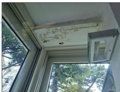
FOTO 98 - INFILTRAZIONE CONTROS.
