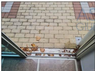
FOTO 94 - PAVIMENTO INTERNO EST.
