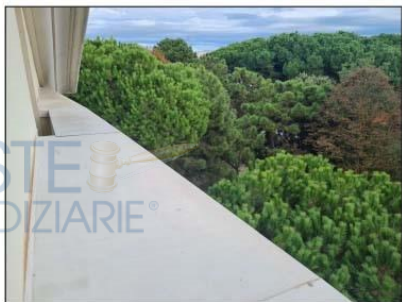
FOTO 13 - VISTA DAL SOTTOTETTO
