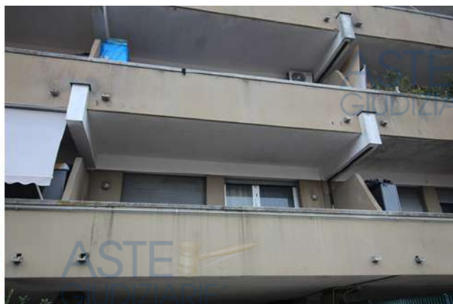
Foto 2: dettaglio prospetto appartamento pignorato
