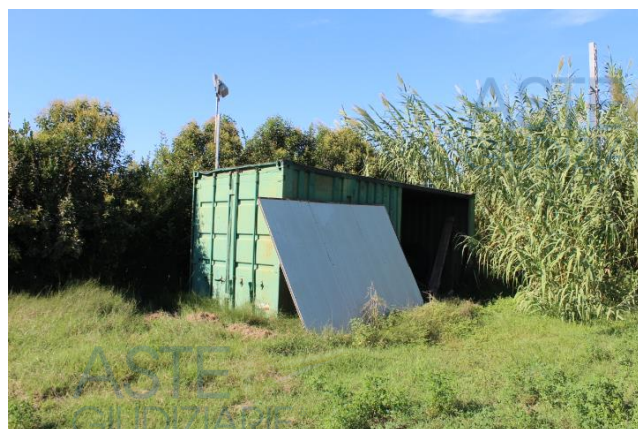
PARTICOLARE DEL MANUFATTO ABUSIVO DA RIMUOVERE INTEGRALMENTE
