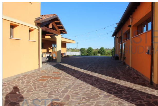
PARTICOLARE DELLA CORTE PAVIMENTATA POSTA FRA I DUE CORPI DI FABBRICA
