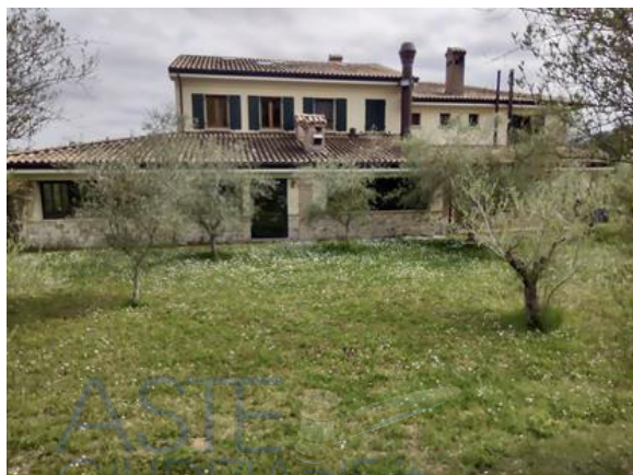
Vista del fabbricato
