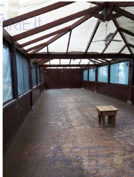
e vista interna su sala pranzo
