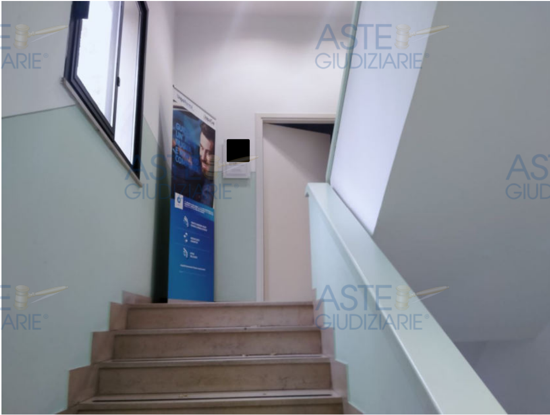
Fot.3 – Vista del vano scale dell'edificio che conduce al piano primo.
