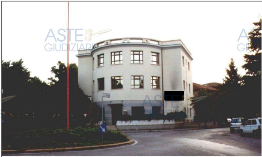
Vista del fronte principale
