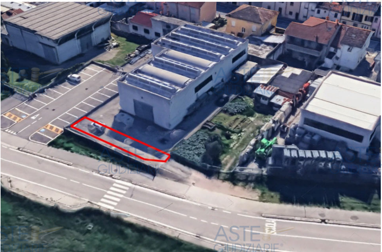
Foto 4- Vista dell'immobile esecutato dall'alto.
