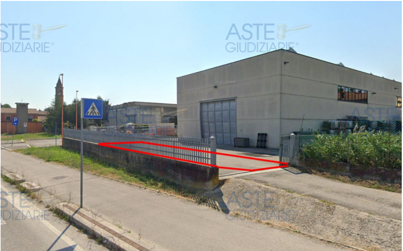
Foto 3- Vista dell'immobile esecutato da Via Olof Palme.
