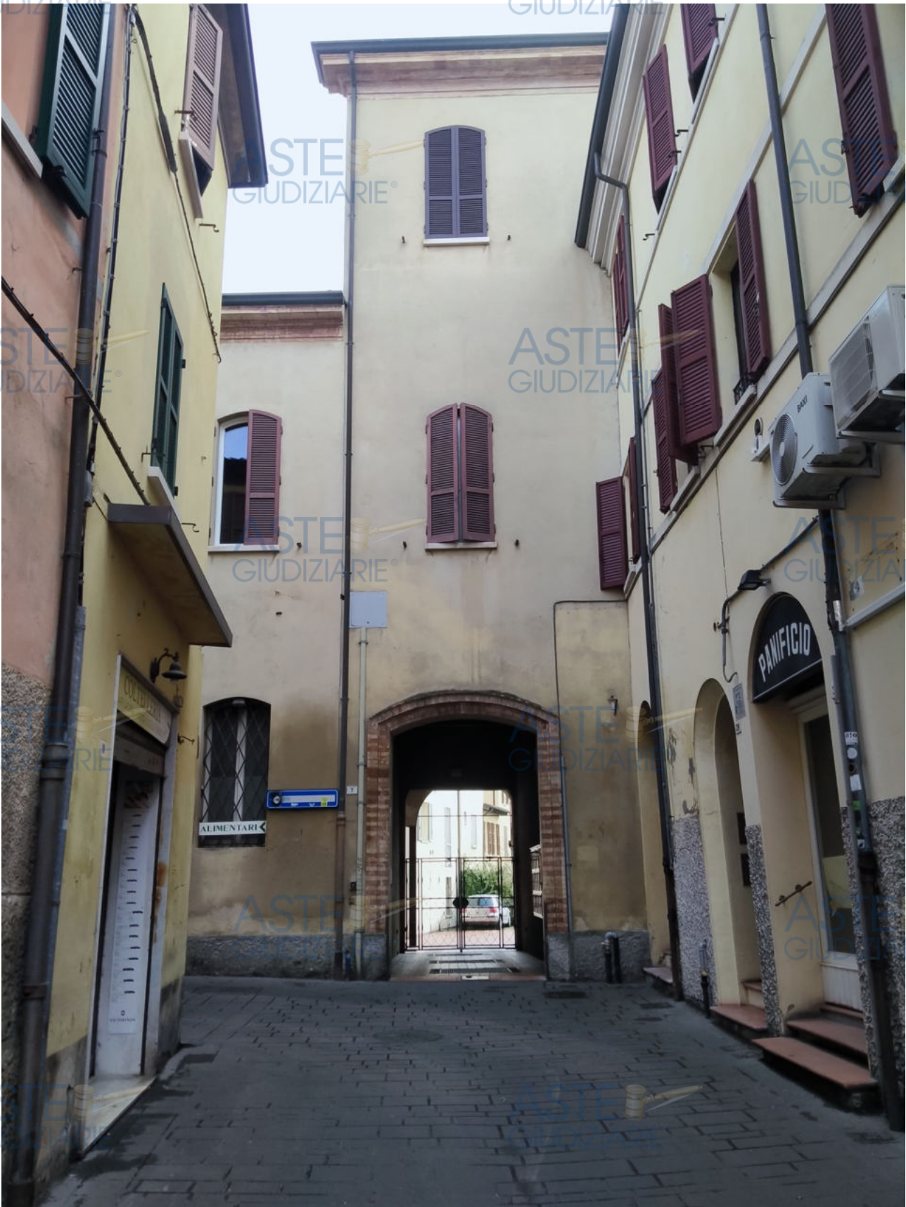
Fot.1 – Vista dell' ingresso al "Palazzo Caporali" dalla Via Verzaglia.
