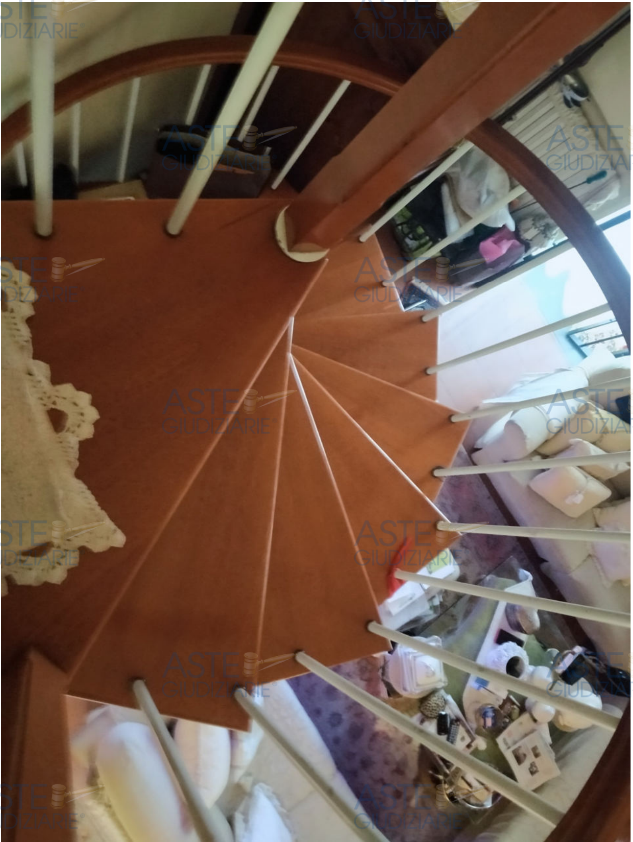
Fot.16 – Dettaglio scala a chiocciola.
