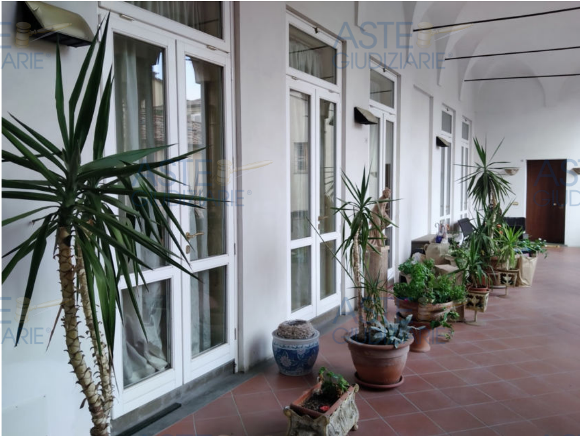
Fot.8 – Vista del loggiato piano primo lato appartamenti.
