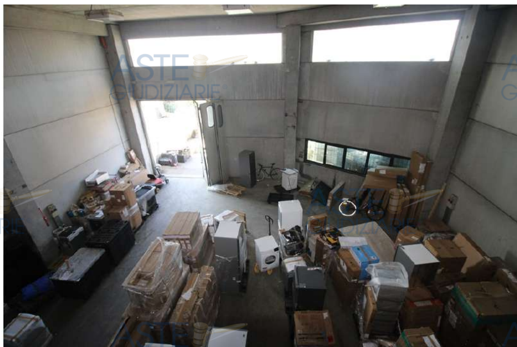
Foto 7: interno del capannone, vista dal piano primo verso la parte di magazzino a doppio volume
