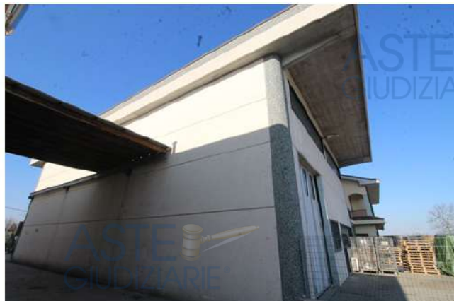
Foto 2: prospetto laterale sud ovest
