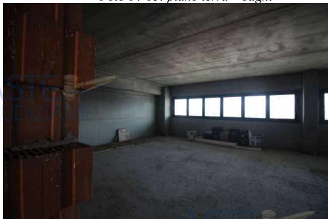
Foto 18-19: piano primo – volume ancora al grezzo con i soli infissi
