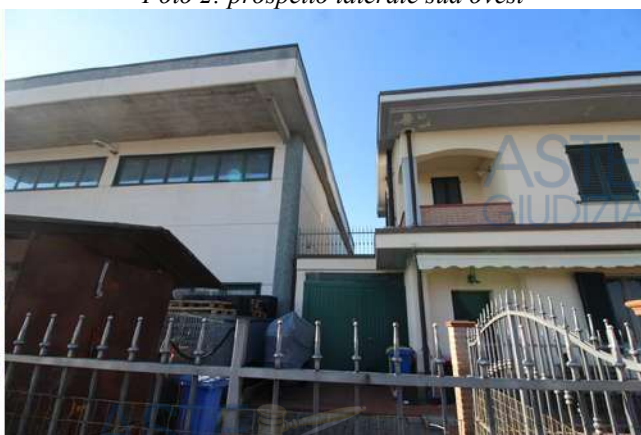
Foto 4: prospetto laterale sud est adiacente a fabbricato uffici uso civile abitazione
