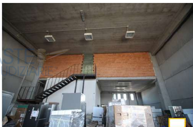
Foto 8: interno magazzino - vista lato via Karlsruhe
