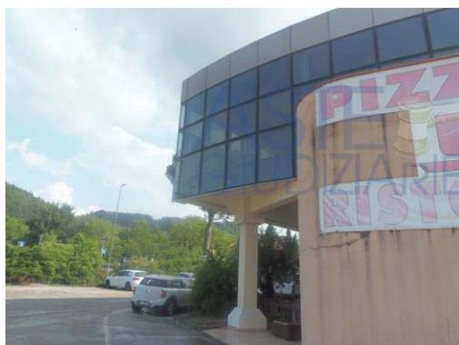
Le facciate esterne dell'immobile sono intonacate e tinteggiate con parti in pannelli di vetro colorato. In alcune zone delle facciate è presente un distacco della tinteggiatura dovute agli agenti atmosferici e alla mancanza di ordinaria manutenzione.
