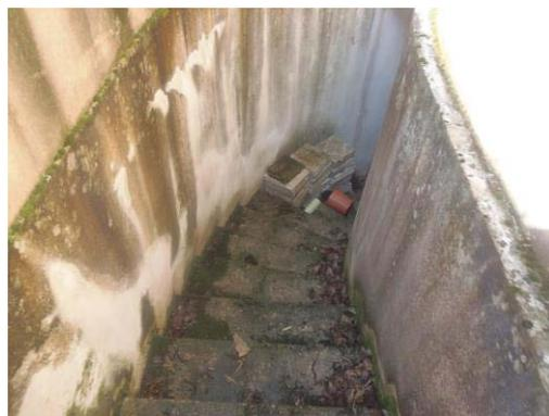
Entrambi gli accessi, per il piano interrato, sono quasi totalmente scoperti, ed in essi sono presenti zone di muffa e con macchie dovute ad infiltrazioni di acqua.
