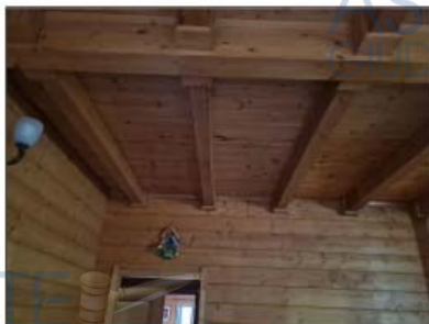
FOTO 58 - STRUTTURA IN LEGNO
