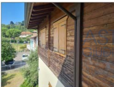
FOTO 23 - PORZIONE FABBRICATO IN LEGNO
