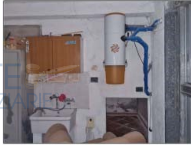
FOTO 62 - ASPIRAZIONE CENTRALIZZATA
