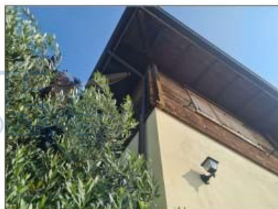
FOTO 22 - DETAGLIO COPERTURA E CORNICIONE IN LEGNO
