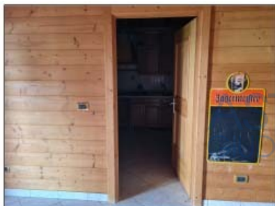
FOTO 55 - PARETI IN LEGNO
