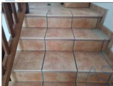
FOTO 71 - DETTAGLIO SCALA INTERNA
