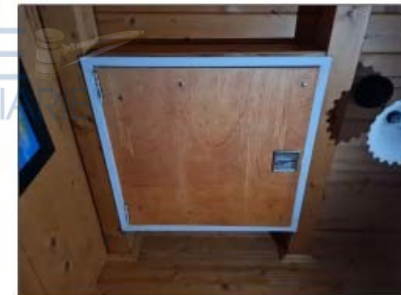
FOTO 69 - BOTOLA DI ACCESSO AL TETTO
