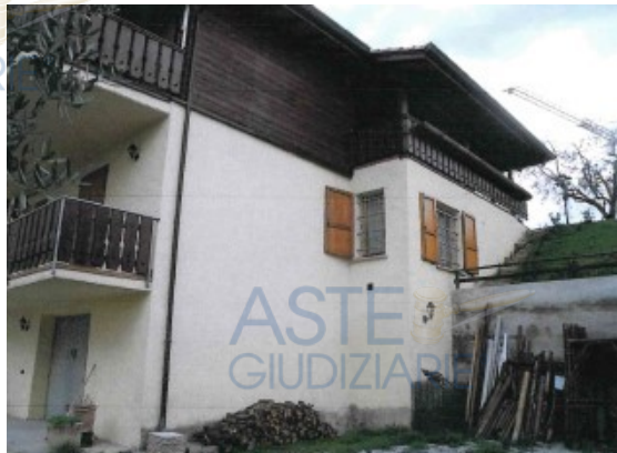
VISTA LATERALE DAL GIARDINO
