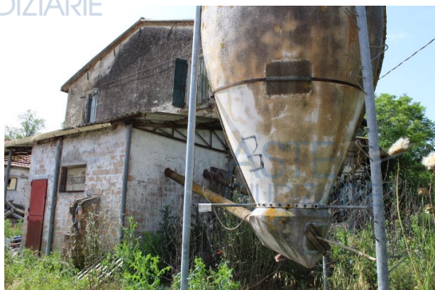
CASA COLONICA, PROSPETTO NORD E PARTICOLARE SILOS
