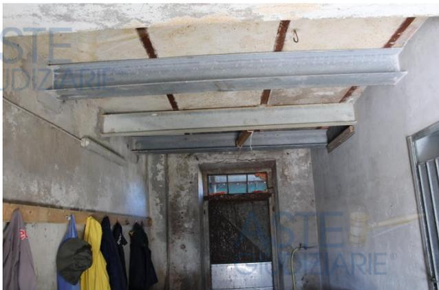
**PARTICOLARE DI RINFORZI IN ACCIAIO DEL SOLAIO PIANO PRIMO**
