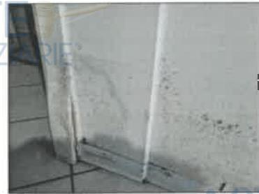
FOTO 33 - Umidità, muffa ed infiltrazioni
