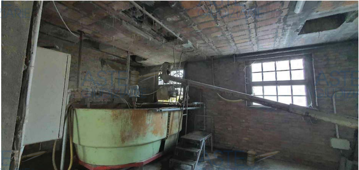
dettaglio solaio interpiano
