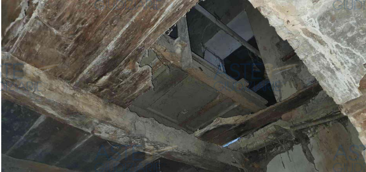
dettaglio solaio interpiano
