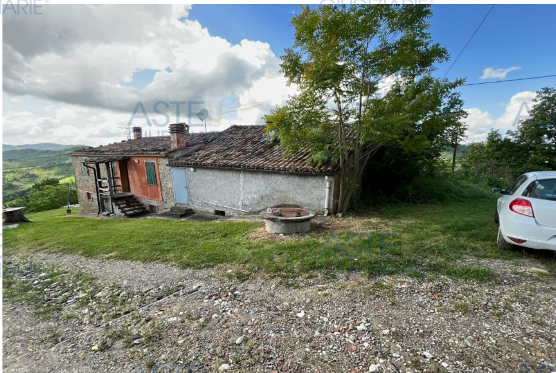
Fot. 01 – Vista generale dell'edificio ubicato nel podere "Piaia Di Sotto", costituito oggi da diverse unità immobiliari.
