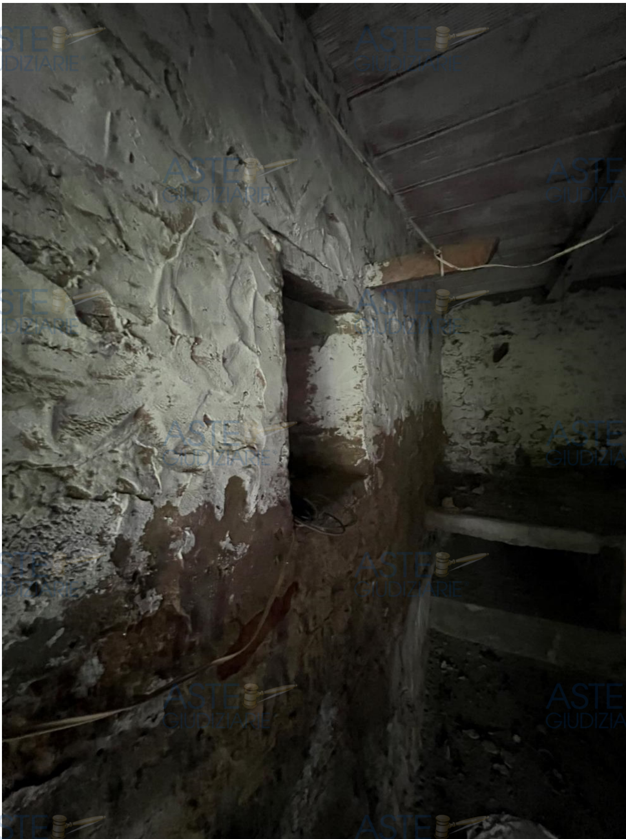
Fot. 07 – Vista della cantina.
