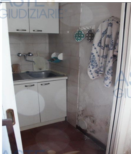
CUCINA; SI NOTANO SEGNI DI UMIDITA' ASCENDENTE
