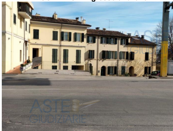
PROSPETTO – Vista palazzo
