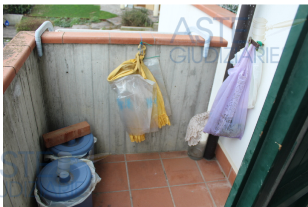
VEDUTA DEL BALCONE CON ACCESSO DALLA CUCINA
