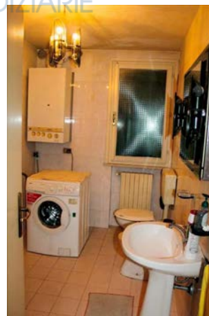
VEDUTA DEL BAGNO AL PIANO TERRA
