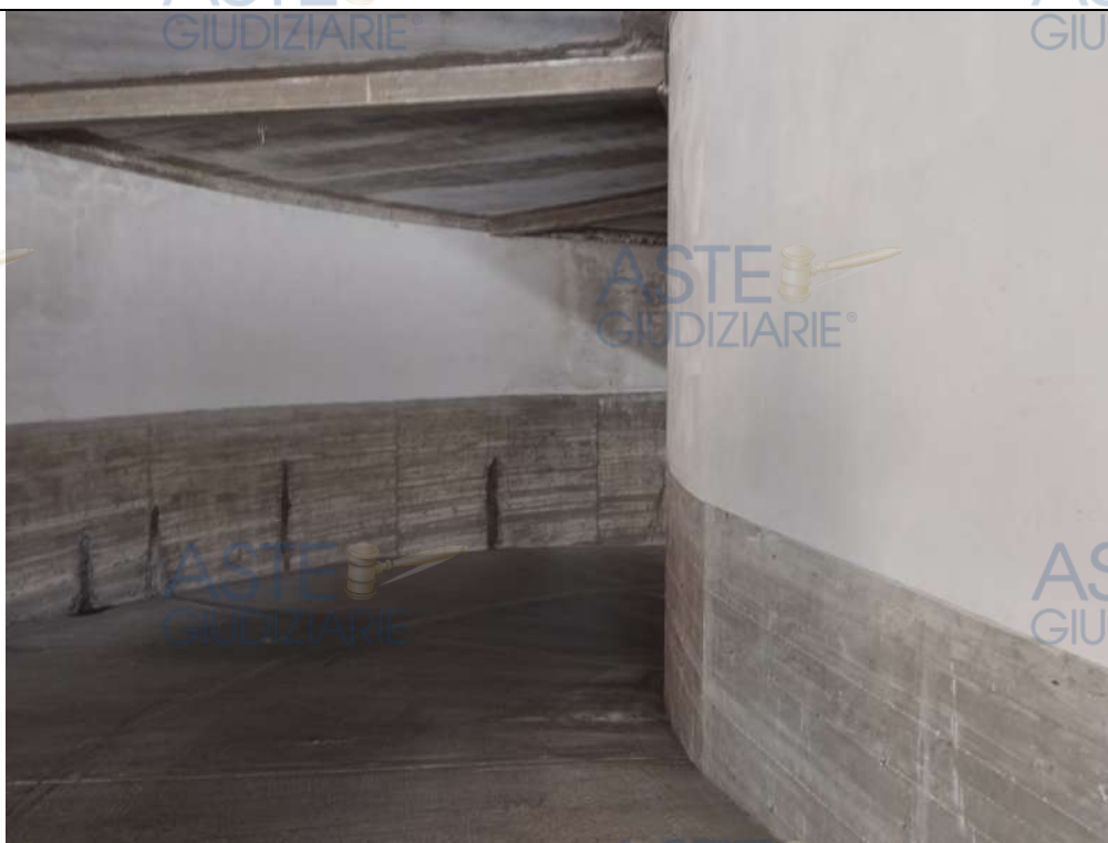
Particolare della rampa
