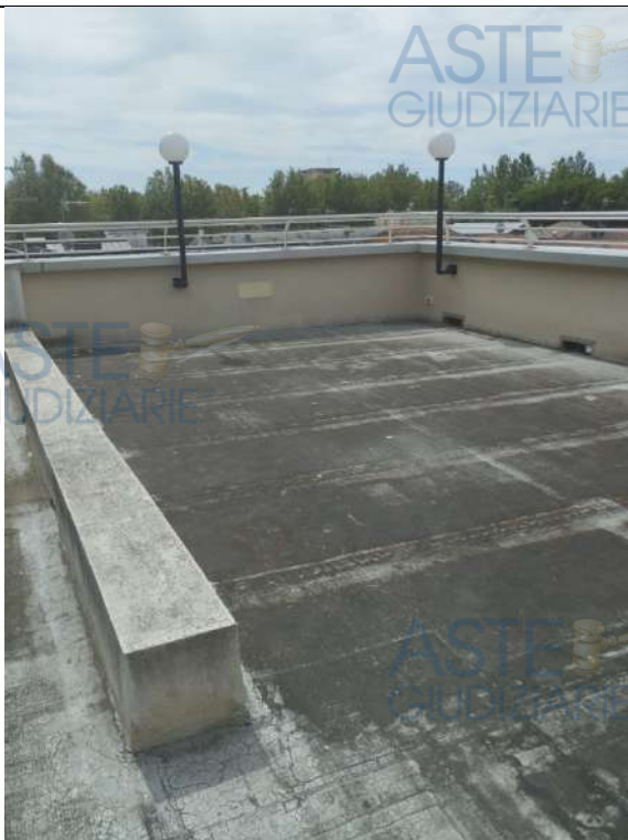
Lastrico solare Sub.14
