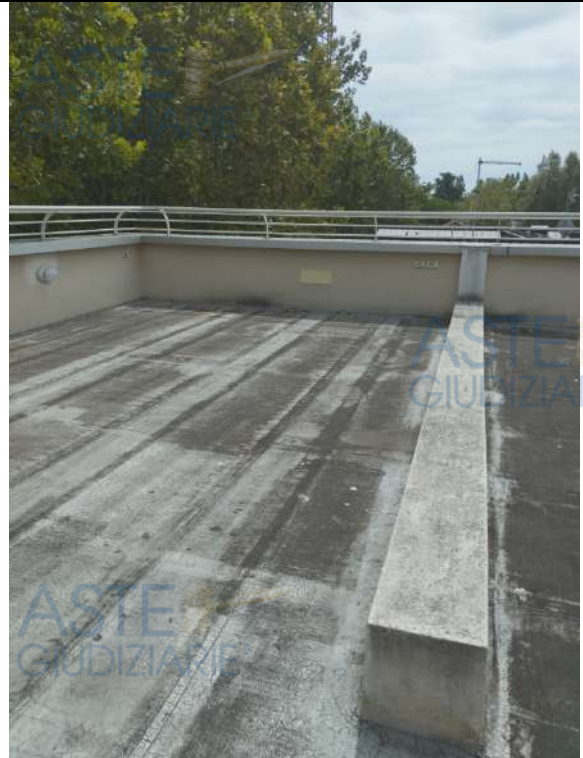
Lastrico solare Sub.15
