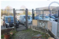
Foto 19: ingresso pedonale alla palazzina
