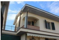
Foto 48: dettaglio prospetto - loggia
