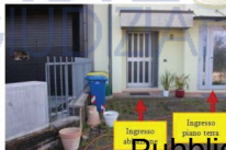
Foto 20: ingressi alla palazzina
