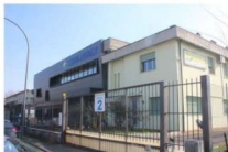
Foto 5: prospetto nord su via Guarini
