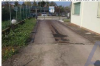
Foto 17: pesa sul lato ovest
