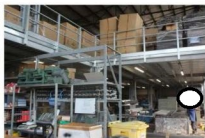
Foto 22: vista soppalco - parte continua e aggettante
