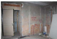
Foto 79: ingresso monolocale dall'interno
