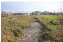
Foto 96: accenno di sottofondo sul sedime stradale
