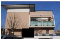
Foto 74: prospetto sud su via Scopeta
