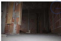
Foto 87: vano al sottotetto
