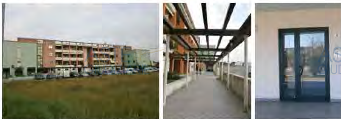
Retro, percorsi comuni e ingresso alla scala condominiale
