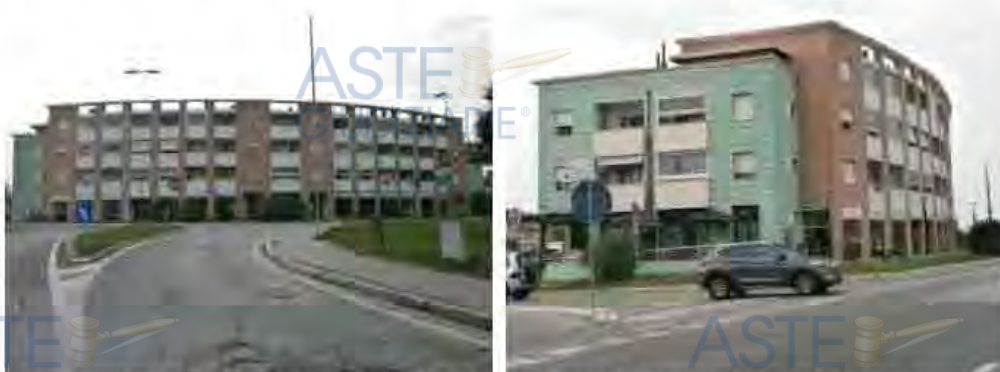
"Condominio Colosseo" che contiene i beni pignorati: fronte su Via Kennedy
