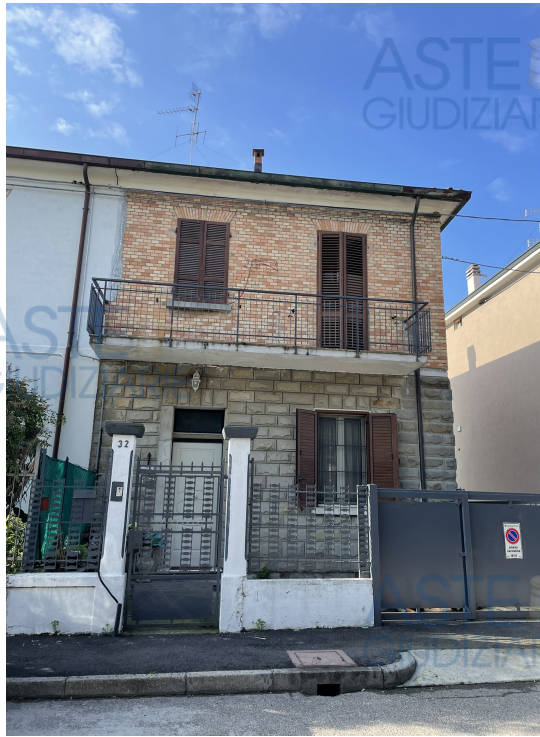
Fronte del fabbricato
