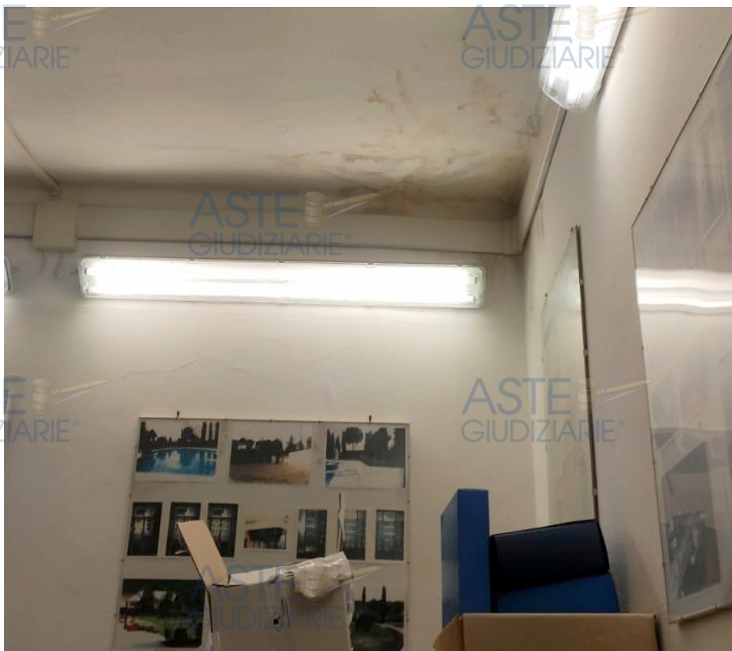
Soffitto ammalorato
